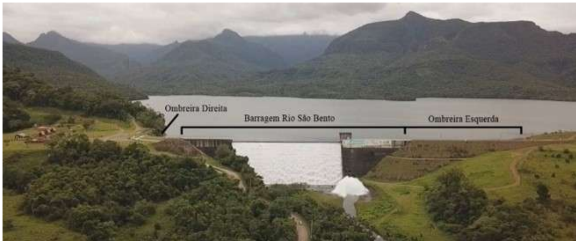
Figura 2 - Fotografia da barragem do rio São Bento.
