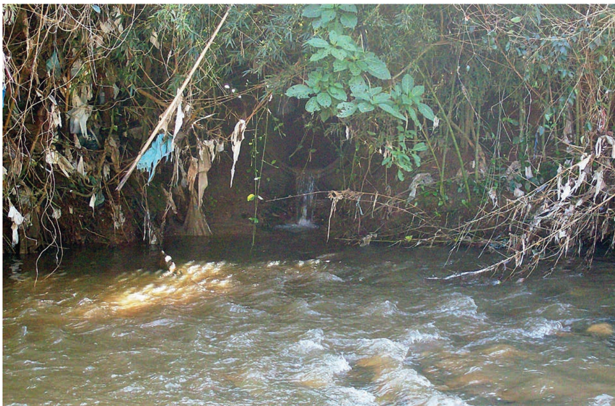
Figura 03: Lançamento da rede de drenagem superficial mista, no Arroio Barnabé
