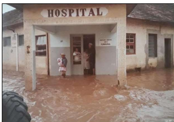
Figura 35. Inundação Julho/1982 – Rua Carlos Huff/Hospital.
