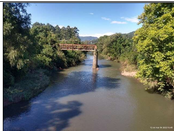
Figura 70. Foto sem inundação – ERS-239/Ponte sobre o Rio Rolante.
