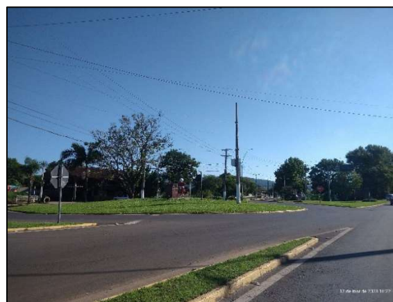
Figura 54. Foto sem inundação – ERS-239/Rótula acesso à cidade.
