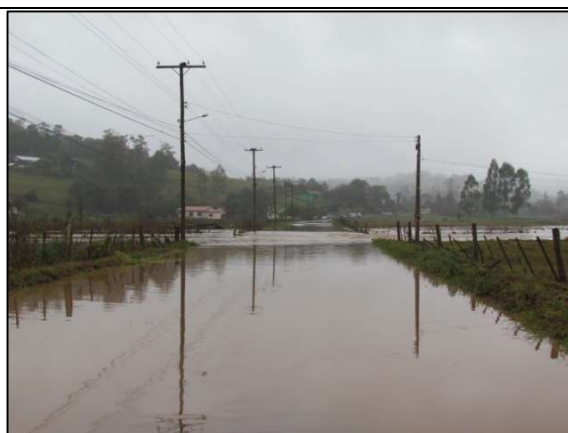
Figura 85. Inundação Julho/2011 – Avenida Anexação.
