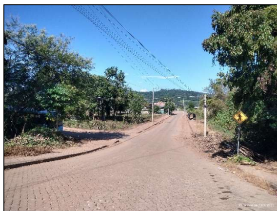
Figura 64. Foto sem inundação – Rua Oscar Alcindo Ritter.
