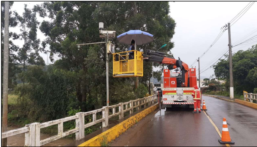
Figura 27. Manutenção da Estação de Monitoramento instalada na Ponte Júlio Schneider, sobre o Rio Rolante. FONTE: Corpo de Bombeiros Voluntários, ago/2022.
