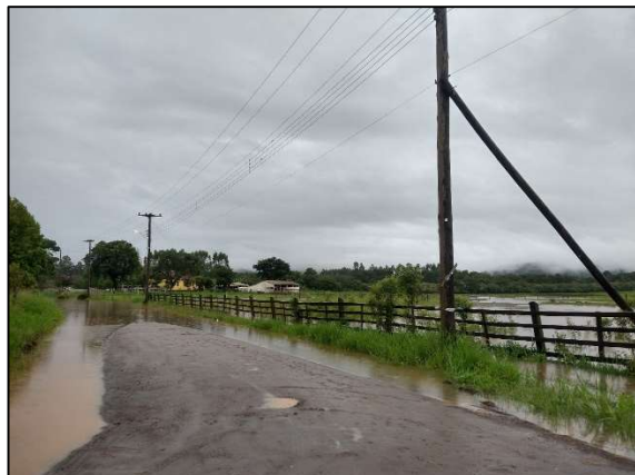
Figura 81. Inundação Março/2023 – Estrada Municipal Linha Reichert.
