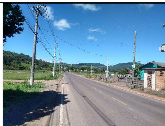
Figura 86. Foto sem inundação – Avenida Anexação.
