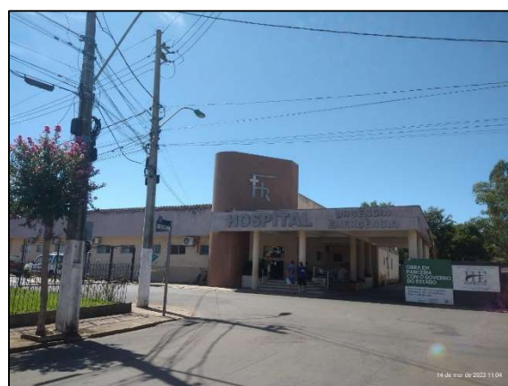
Figura 36. Foto sem inundação – Rua Carlos Huff/Hospital.
