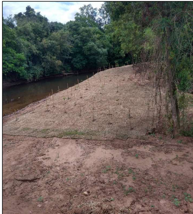
Figura 11. Plantio de recuperação ciliar realizado após as obras de desassoreamento do Rio Areia, em Rolante.
