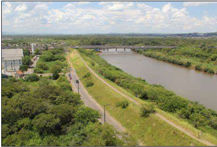
Figura 5. Dique de proteção no município de São Leopoldo/RS.
