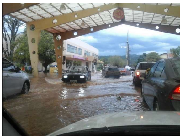
Figura 39. Inundação Julho/2015 – Avenida Getúlio Vargas/Rua Coberta.
