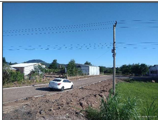
Figura 74. Foto sem inundação – ERS-239 acesso a Rua Heitor Arlindo Berg.
