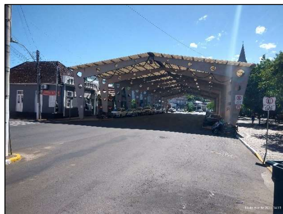
Figura 40. Foto sem inundação – Avenida Getúlio Vargas/Rua Coberta.
