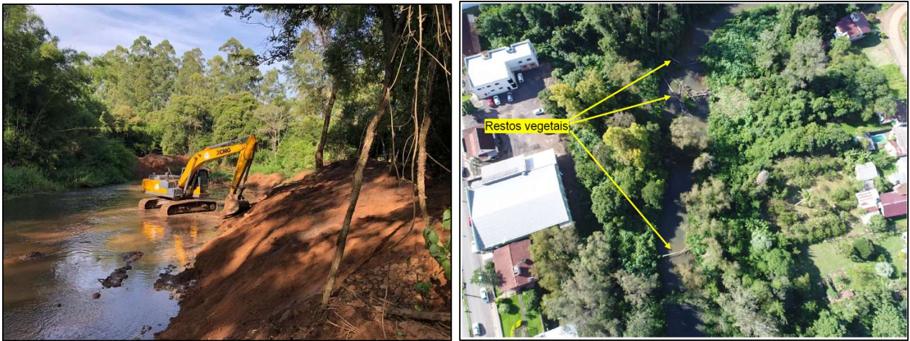
Figuras 7 e 8. Foto do desassoreamento do Rio Areia, em Rolante, realizado em 2019; Foto de barramentos vegetais.
