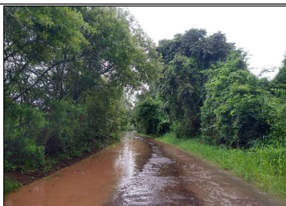
Figura 71. Inundação Março/2023 – Estrada Municipal Fazenda Passos.
