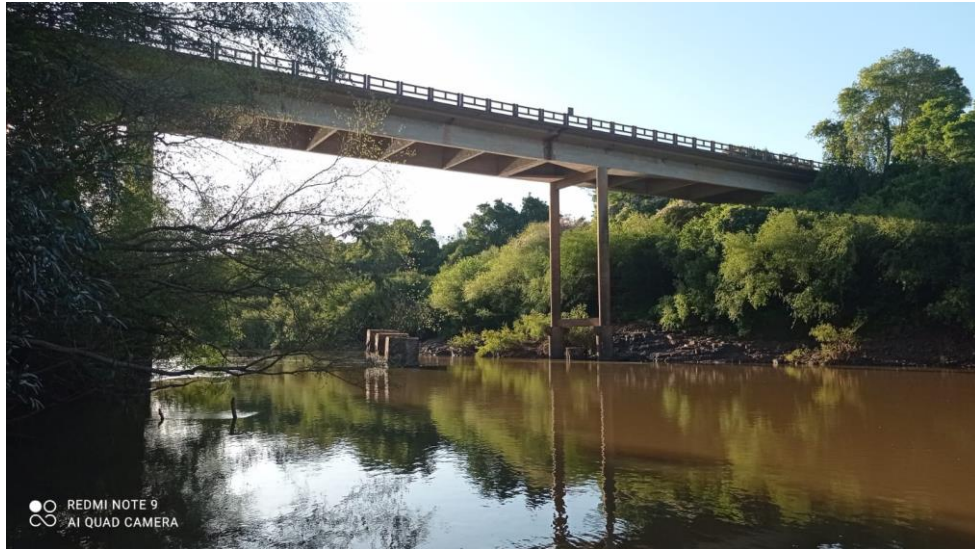
Figura 12– Ponte sobre o Rio Piratinim, município de São Luiz Gonzaga
