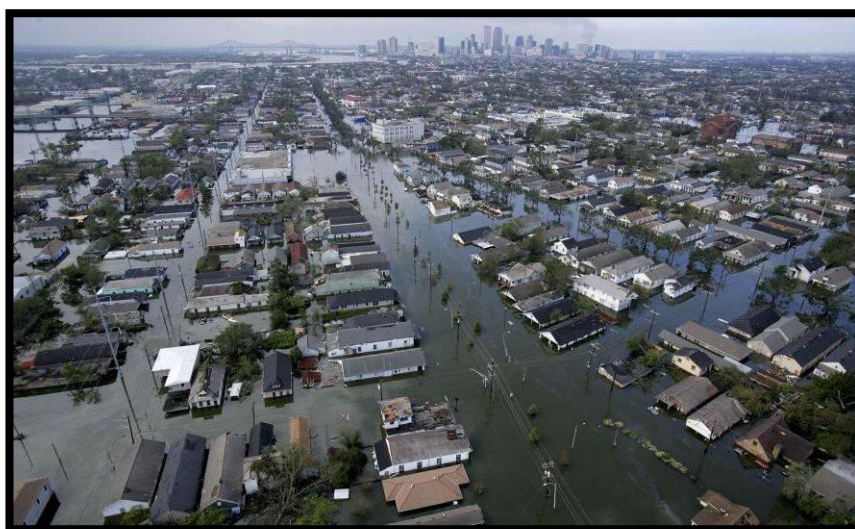
Figura 51 – Vista de Nova Orleães inundada após a passagem do furacão Katrina em 2005. (fonte: https://media.gazetadopovo.com.br/2019/08/21125259/katrinaafpbaixa.jpg )
