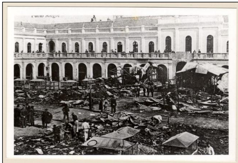
Figura 1: Bancas centrais do Mercado destruídas após o incêndio de 1912.
