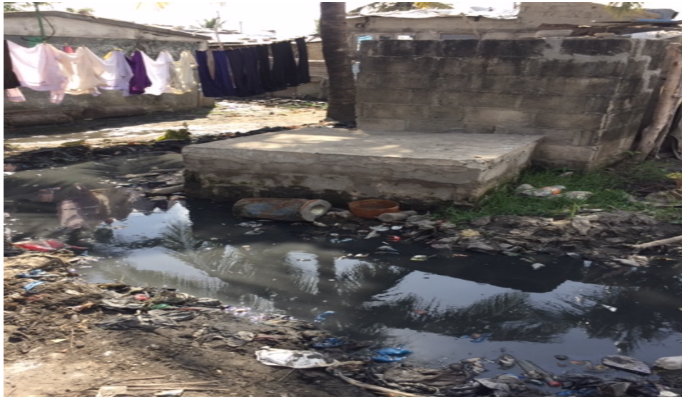
Figura 16: Imagem de um banheiro e sua fossa séptica construída no Munhava-Matope
