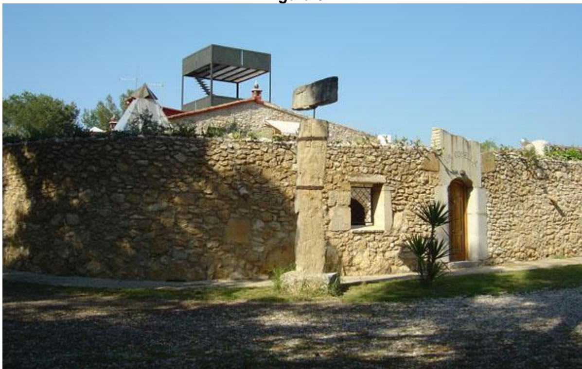
Fachada sul de La Comella .
