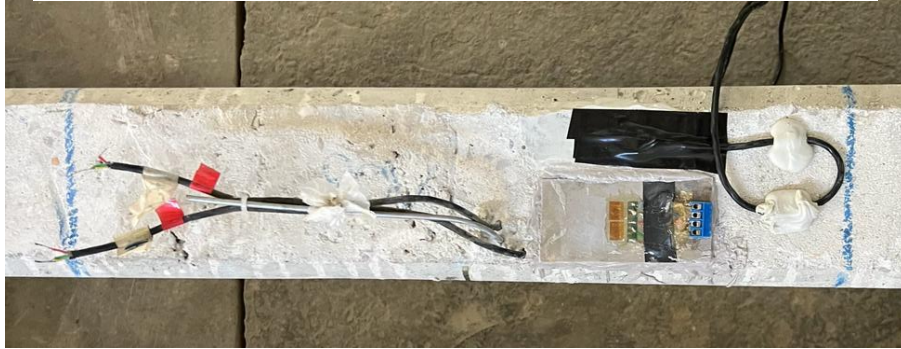
Figura 45 – Terço central da viga com sensores fixados
