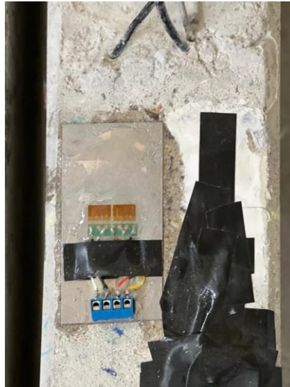
Figura 43 - Placa com extensômetros fixada na viga
