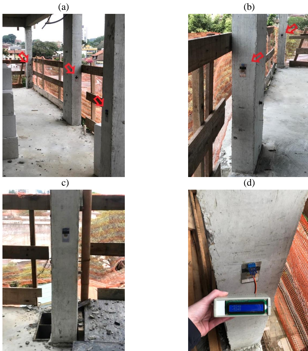
Figura 30 - Placas fixadas nos pilares (a) P2, P4 e P6; (b) P1 e P3; (c) P8; (d) Dispositivo de leitura conectado à placa
