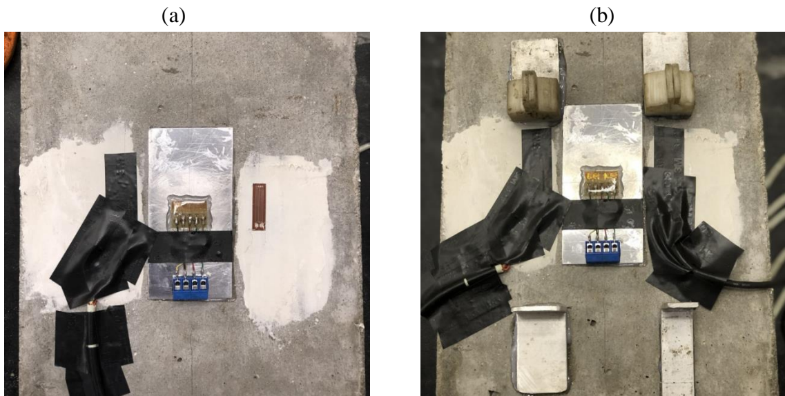
Figura 25 – Pilar com sensores (a) Instalação dos extensômetros (b) Instalação das cantoneiras
