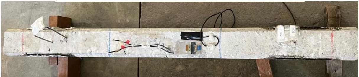
Figura 46 – Localização dos sensores fixados na viga
