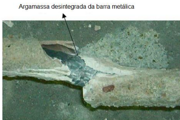
Figura 18 – Resultado da interface argamassa-barra metálica através de ensaio experimental
