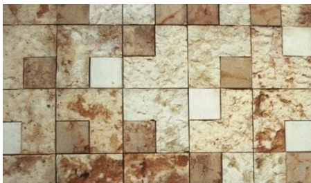
Figura 166 – Imagem do trabalho em pedra travertino verona da fachada e a sua
