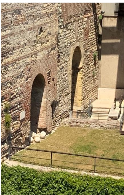
Figura 92 – Fosso interno reescavado e, ao fundo, a Porta del Morbio Fonte: Foto da autora, visita em abril de 2022.
