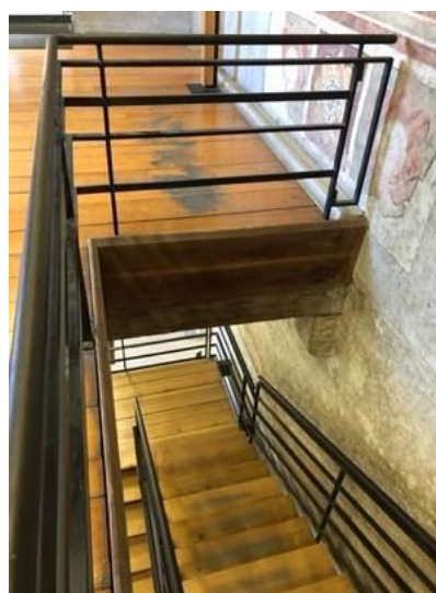
Figura 85 – Vista superior da escada Fonte: Foto da autora, visita em abril de 2022.
