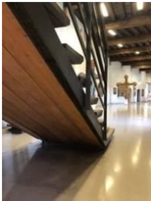
Figura 79 – Detalhe do fechamento inferior em madeira Fonte: Foto da autora, visita em abril de 2022.
