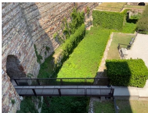
Figura 137 – Vista superior ponte metálica e o fosso interno reescavado Fonte: Foto pela autora em visita abril 2022.
