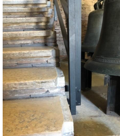
Figura 113 – Detalhes degraus. Pedras avançam e sobrepõem com negativo Fonte: Foto da autora, visita em abril de 2022.
