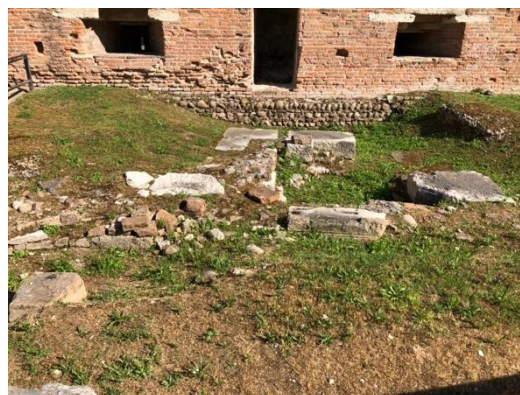
Figura 127 – Fundações em ruínas da Igreja San Martin di Aquaro, junto ao muro Fonte: Foto da autora, visita em abril de 2022.
