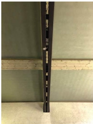
Figura 211 – Estrutura metálica com trilho de iluminação embutido Fonte: Foto pela autora em visita abril 2022.
