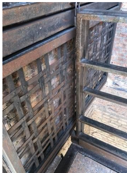
Figura 229 – Detalhe da chegada do corrimão junto à porta de entrada da Ala Reggia
