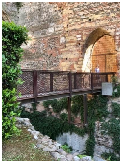
Figura 136 – Ponte do fosso interno e sua estrutura metálica tensionada Fonte: Foto pela autora em visita abril 2019.
