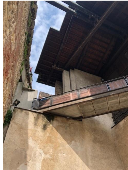
Figura 192 – Vista inferior da passarela entre Ala Reggia e Galeria de Pinturas do 2º pav. Fonte: Fotos pela autora em visita abril 2019.
