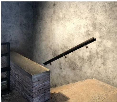
Figura 239 – Reboco texturizado na Torre del Mastio Fonte: Foto pela autora em visita abril 2022.
