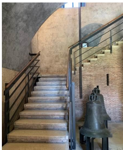
Figura 112 – Escada com detalhes de alvenaria, de inspiração tipicamente romana, revestimento em pedra e corrimão metálico com madeira Fonte: Foto da autora, visita em abril de 2022.
