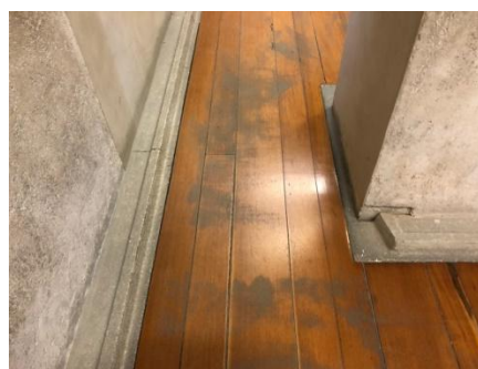
Figura 238 – Detalhe entre piso e parede Fonte: Foto pela autora em visita abril 2022.
