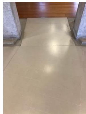
Figura 75 – Encontro do piso polido com o piso de madeira
