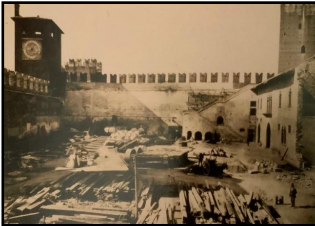
Figura 26 – Demolições de 1923 a 1925, restauro de Antonio Avena Fonte: MURPHY, Richard. Carlo Scarpa and Castelvecchio Revisited . Breakfast Mission Publishing, 2017, p. 18-19.
