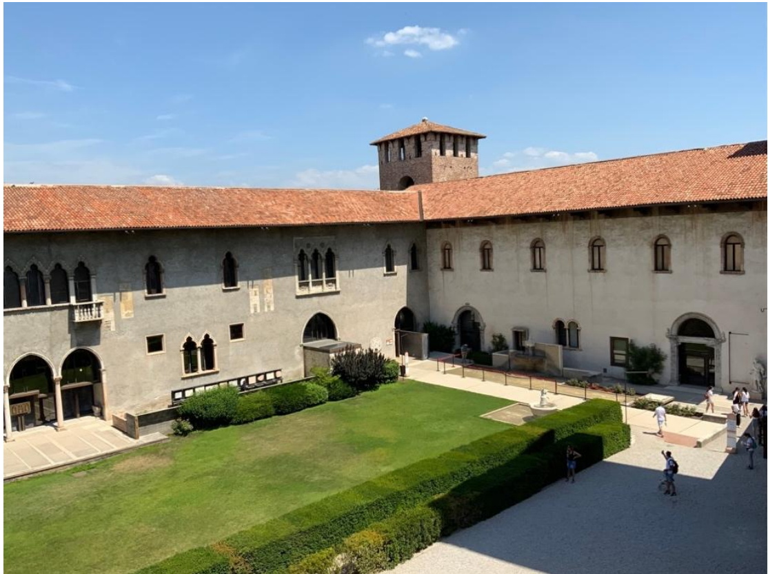
Figura 144 – Vista da fachada leste da Ala della Galleria no seu contexto
