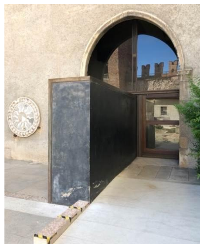
Figura 149 – Vista frontal, entrada e saída
