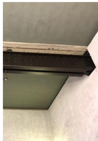
Figura 213 – Chegada estrutura metálica na parede existente e na função estrutural junto ao forro Fonte: Foto pela autora em visita abril 2022.
