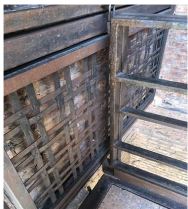
Figura 60 – Detalhes do encontro do corrimão com a grade de proteção
