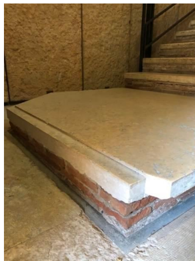
Figura 117 – Detalhe degrau convite Fonte: Foto da autora, visita em abril de 2022.
