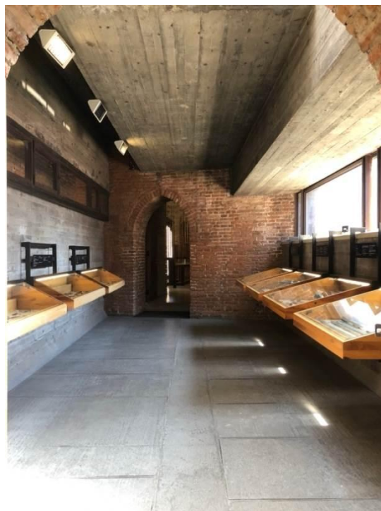
Figura 104 – Visual da reforma já com o mobiliário expositor Fonte: Foto da autora, visita em abril de 2022.
