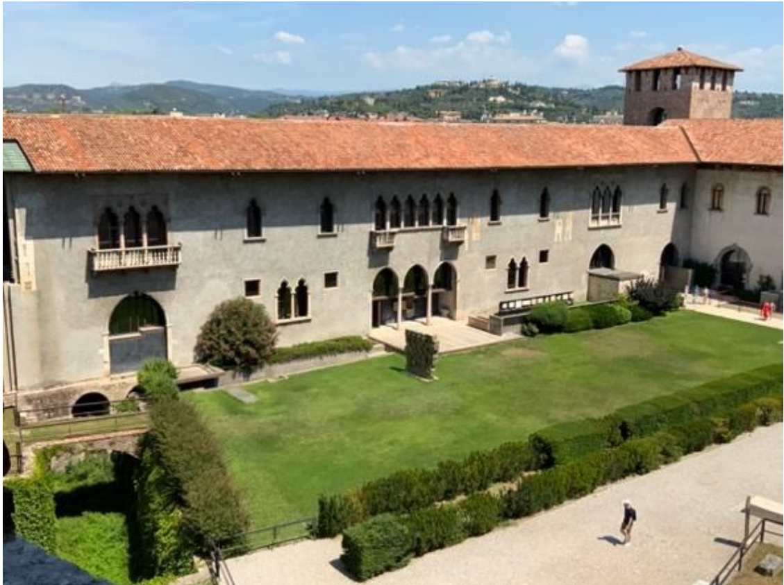
Figura 141 – Fachada da Ala della Galleria , com o Jardim Principal
