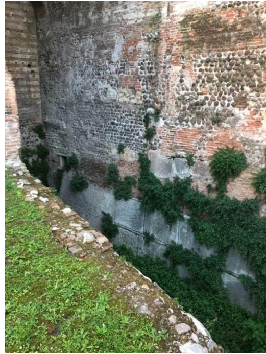
Figura 131 – Fosso interno reescavado | Fundações da muralha medieval aparentes Fonte: Foto da autora, visita em abril de 2022.
