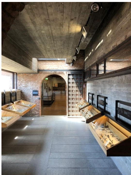
Figura 105 – Visual da reforma já com o mobiliário expositor Fonte: Foto da autora, visita em abril de 2022.
