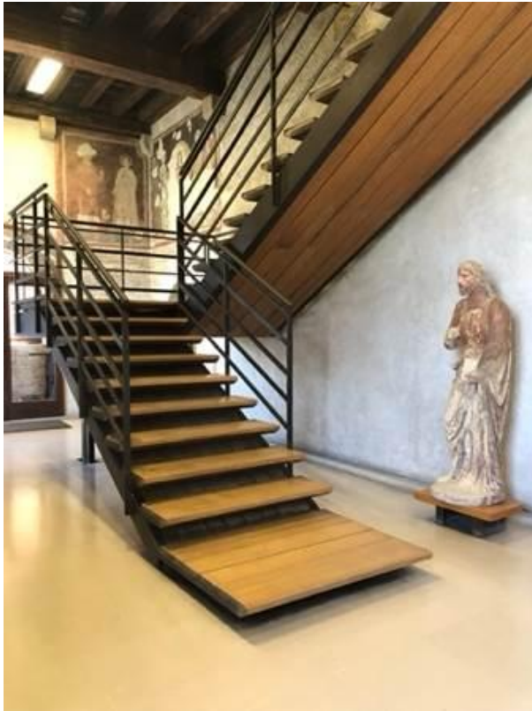
Figura 77 – Escada principal com degrau convite da Ala Reggia Fonte: Foto da autora, visita em abril de 2022.
