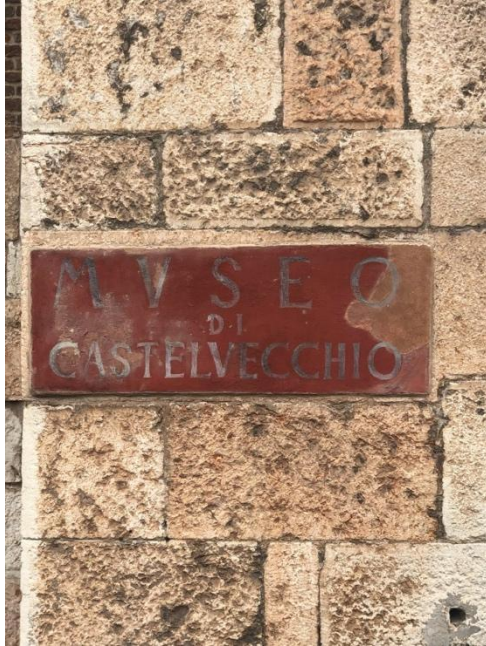
Figura 48 – Pedra travertino calvário branco na porta de entrada do Castelvecchio Fonte: Fotos tiradas em abril de 2019 em visita realizada pela autora.
