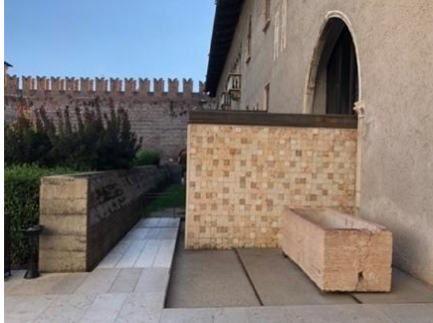
Figura 165 – Imagem do Il Sacello externa com a sua inserção na fachada, o desnível do piso, exposição da banheira romana e a mureta de concreto
