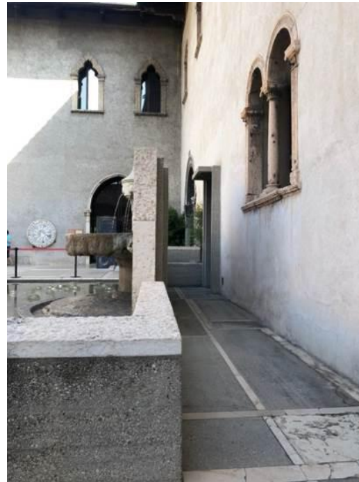
Figura 143 – Detalhe da fachada leste, acesso de serviços
