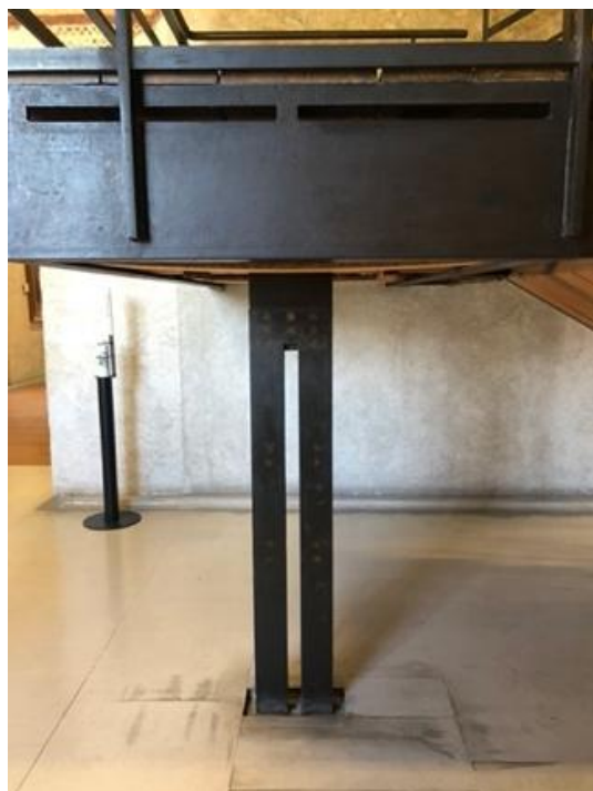
Figura 83 – Detalhe do apoio do patamar da escada Fonte: Foto da autora, visita em abril de 2022.
