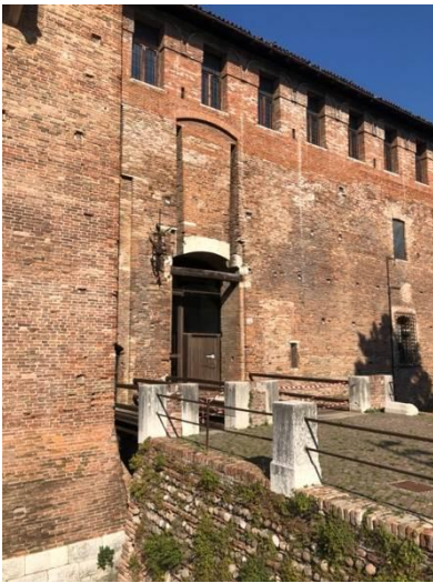
Figura 252 – Porta nova de acesso secundário ao castelo e sua ponte
