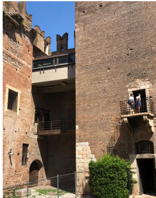
Figura 108 – As duas pontes de ligação entre Mastio e Reggia
