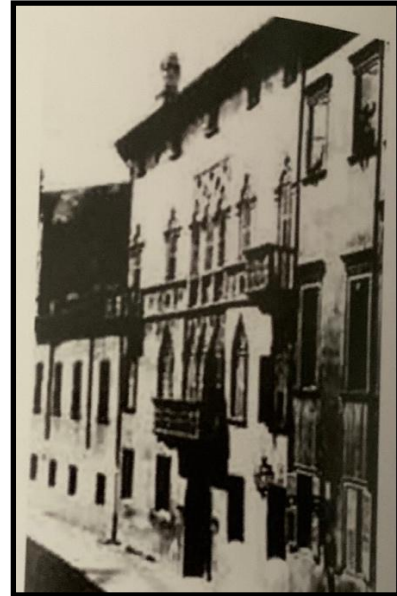
Figura 29 – Palácio Veronese usado na fachada do Pavilhão Napoleônico Fonte: MURPHY, Richard. Carlo Scarpa and Castelvecchio Revisited . Breakfast Mission Publishing, 2017, p. 18-19.
