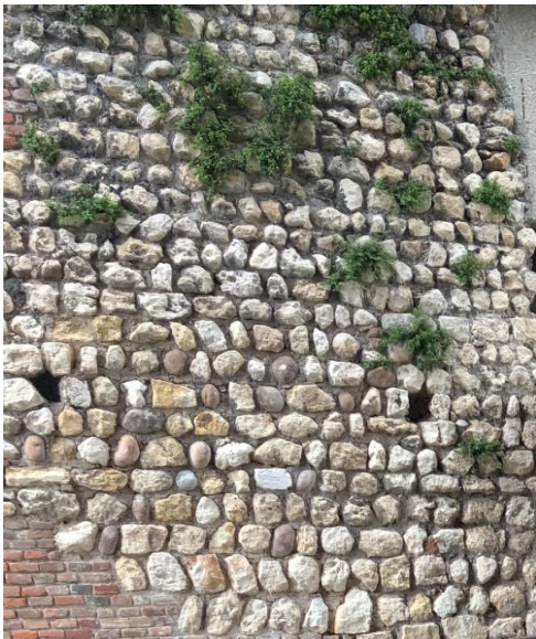
Figura 49 – Detalhe do muro comunal; pedras de rios misturadas com pedra calcária e tijolos Fonte: Fotos tiradas em abril de 2019 em visita realizada pela autora.
