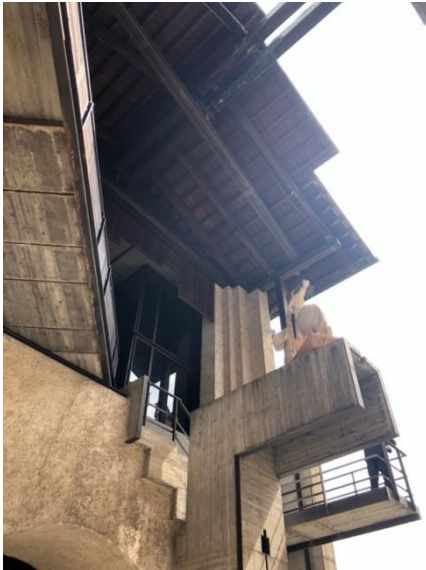
Figura 189 – Vista inferior do zigurate, pela saída da Galeria das Esculturas, no 1º pav. Fonte: Fotos pela autora em visita abril 2019.
