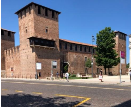
Figura 251 – Vista lateral castelo junto com a Piazza Monforte
