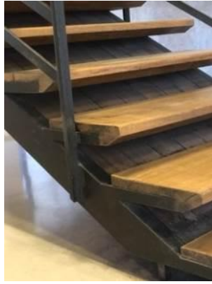
Figura 80 – Detalhe do degrau da escada com parte da base do corrimão Fonte: Foto da autora, visita em abril de 2022.
