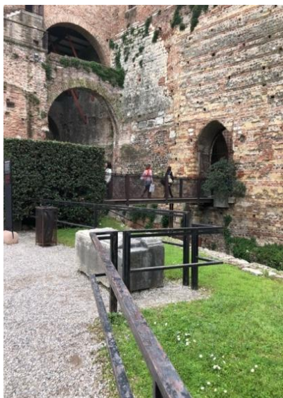
Figura 135 – Fosso interno protegido e Ponte de Scarpa, que leva à passagem Fonte: Foto pela autora em visita abril 2019.
