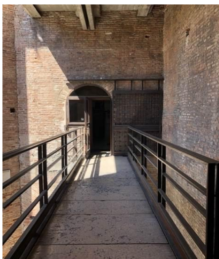
Figura 56 – Passarela de acesso principal para Ala Reggia , passando pela Torre del Mastio.
