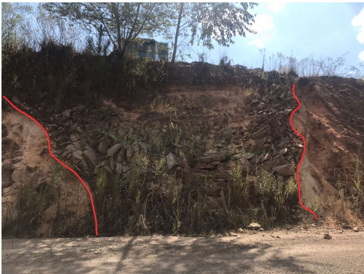
Figura 20 - Contato entre a UV1 e a UV2 evidenciando o paleorelevo formado pela UV1, sendo esse uma feição do tipo vale.
