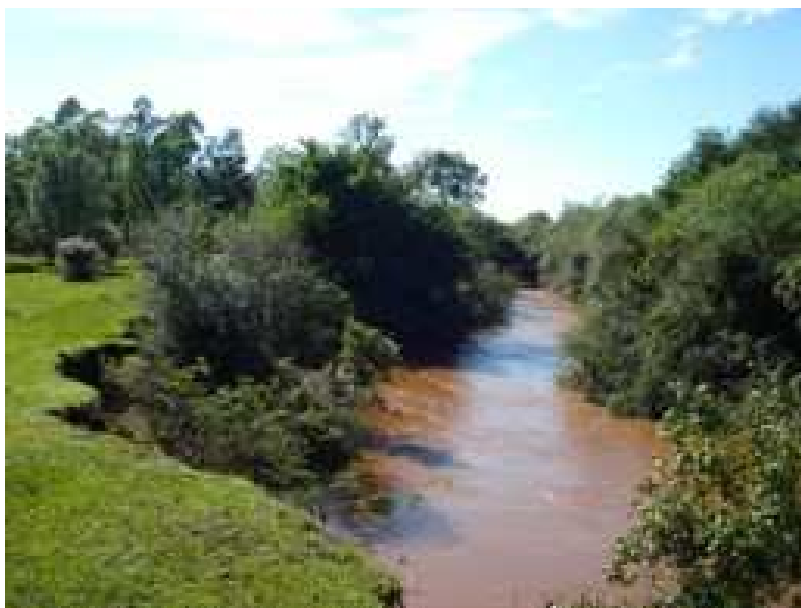
Figura 15: Processo de Erosão e Contenção das Margens do Rio Santo Cristo no Setor 2 Fonte: foto de Sidnei Luís Bohn Gass, 29/11/09.
