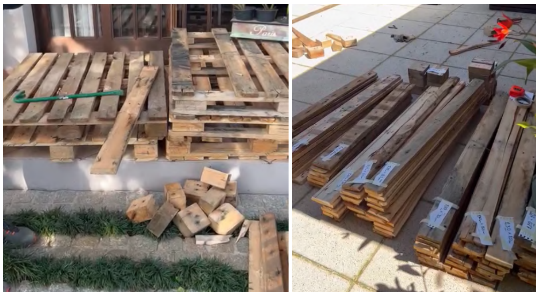
Figura 43 e 44 - Desmonte e organização dos pallets.
