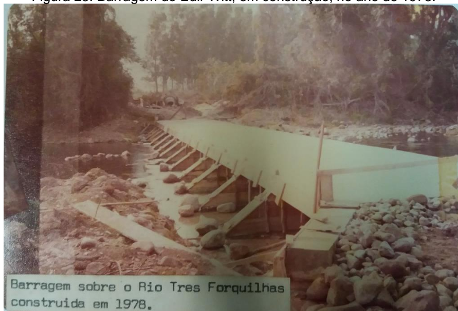
Figura 25: Barragem do Edir Witt, em construção, no ano de 1978.
