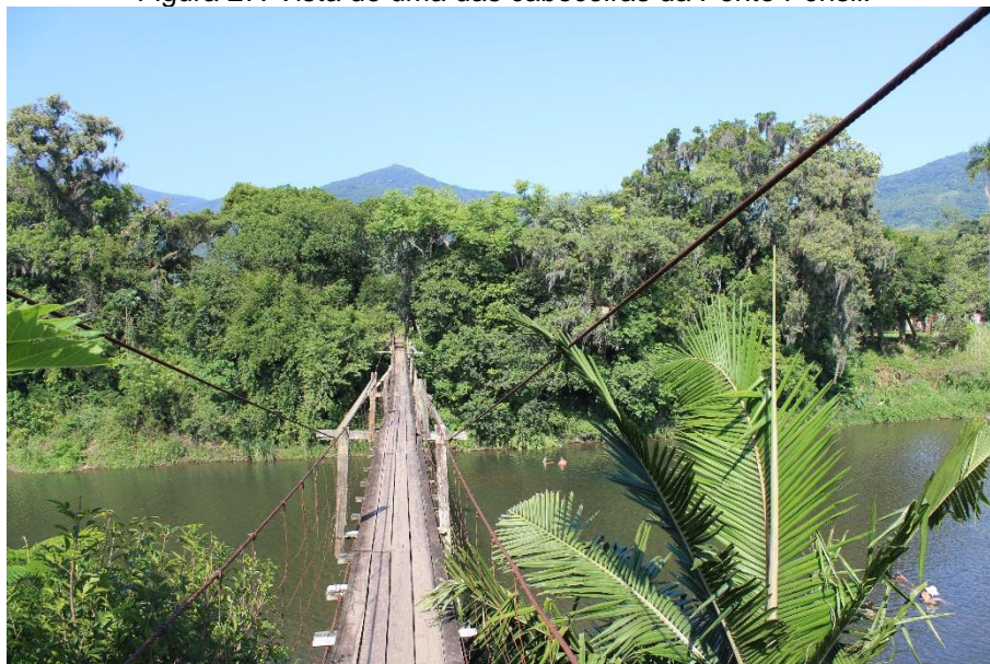
Figura 27: Vista de uma das cabeceiras da Ponte Pênsil.
