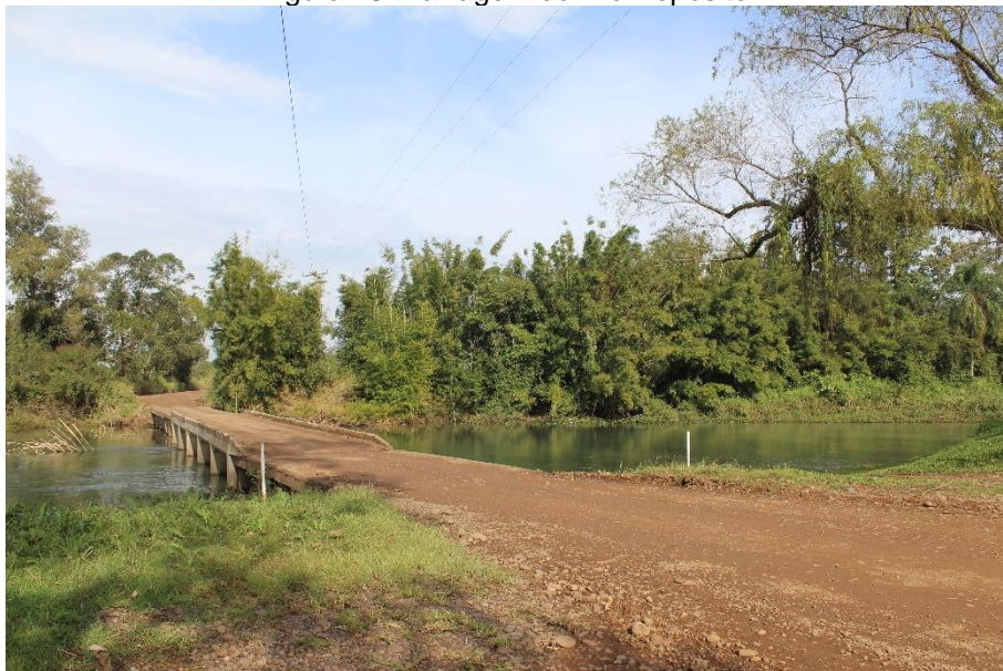
Figura 29: Barragem do Rio Depósito.
