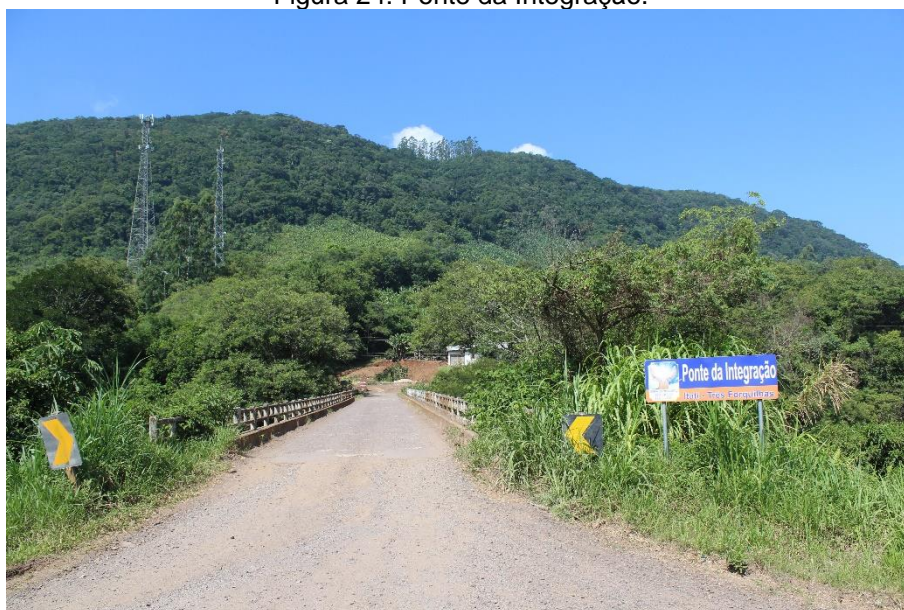
Figura 24: Ponte da Integração.
