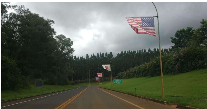
Figura 22 – Estrada de acesso à CBMM (Araxá/MG)
