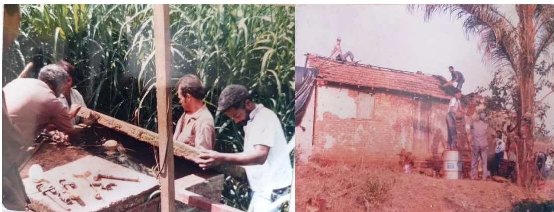
Figura 32 – Mutirões da AMB para construção/reforma de casas (Barreiro, Araxá)
