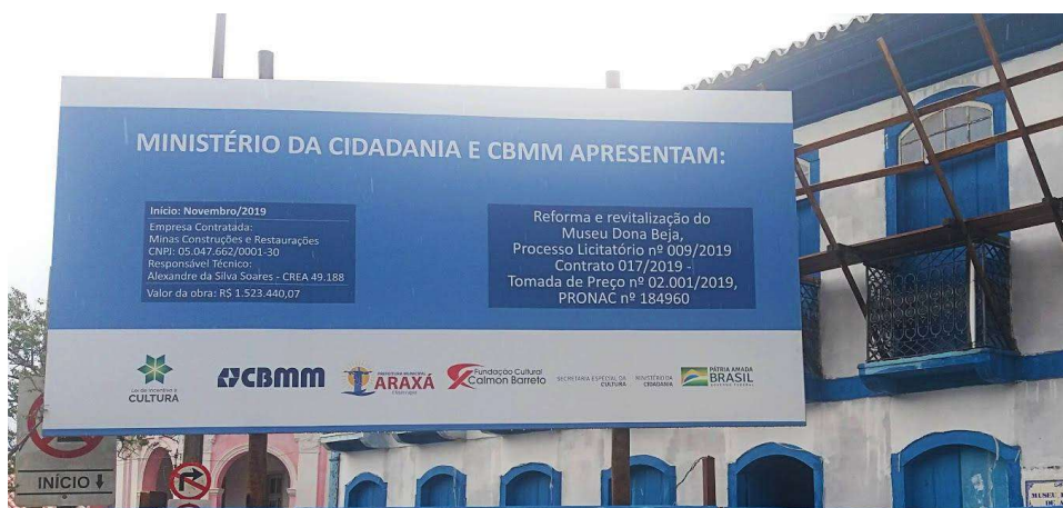
Figura 16 – Placa em frente à obra de restauração do Museu Dona Beja (2020)
