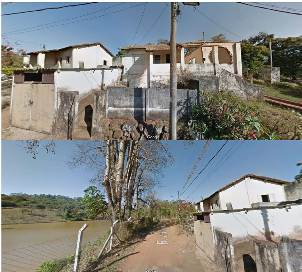
Figura 44 – Ruínas das casas da rua Vila Operária (2011)
