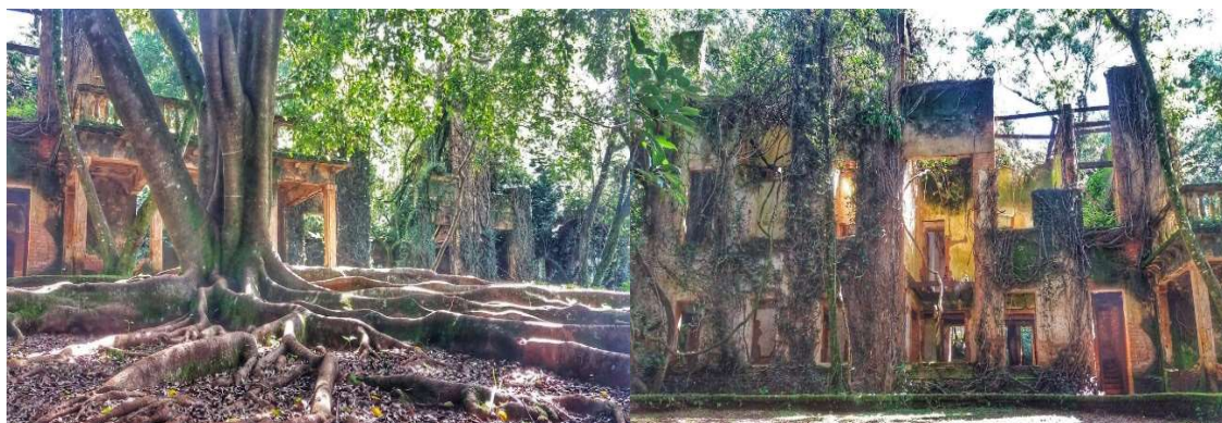
Figura 31 – Ruínas do Hotel Rádio (Araxá/MG)
