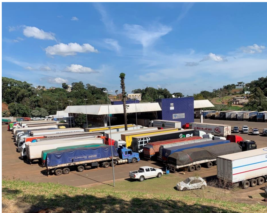
Figura 16 - Porto Seco de Dionísio Cerqueira (SC) e Área de Controle Integrado
