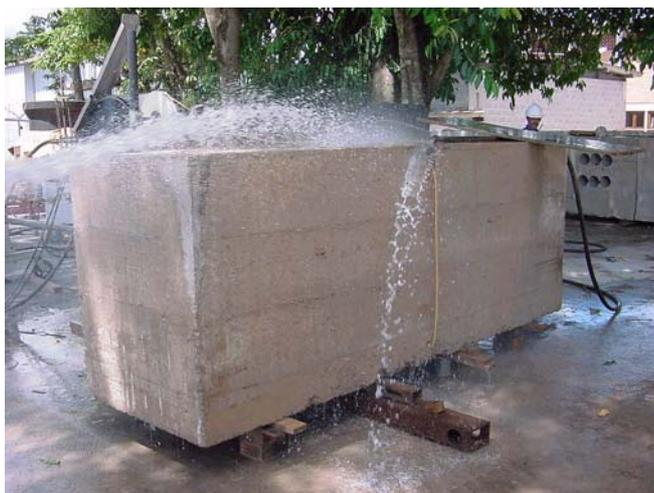
**FIGURA 5.38** Corte com fio diamantado
