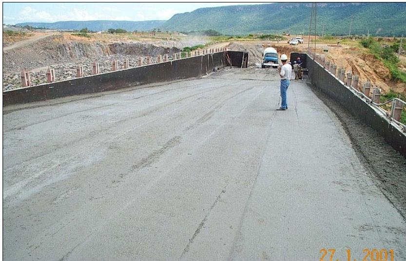
**FIGURA 2.46** Aplicação do CCR Rampado na UHE Lajeado
