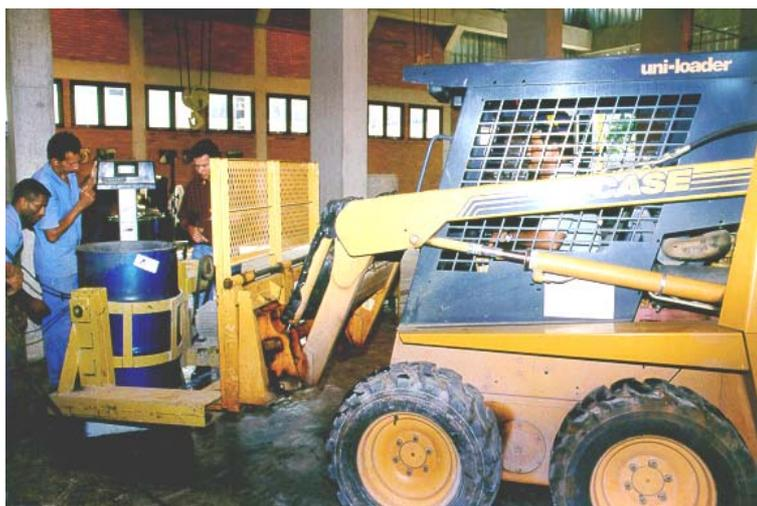
**FIGURA 5.22** Pesagem dos Materiais e Abastecimento da Betoneira de 1,5 m<sup>3</sup>
