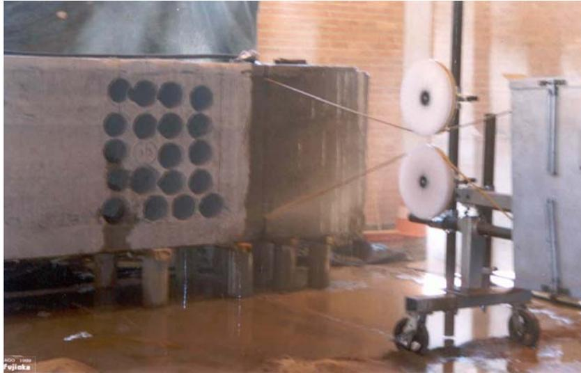
**FIGURA 5.13** Corte com Serra de Fio Diamantado
