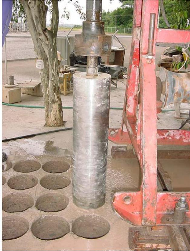
**FIGURA 5.9** Detalhe do Início do Processo de Perfuração
