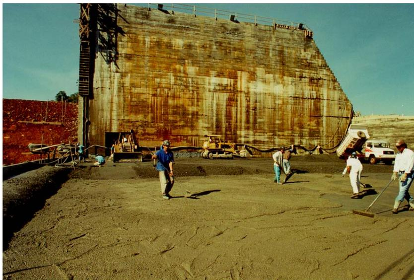
**FIGURA 2.29** Detalhe de Espalhamento de Argamassa, Face de Montante e Juntas de Contração
