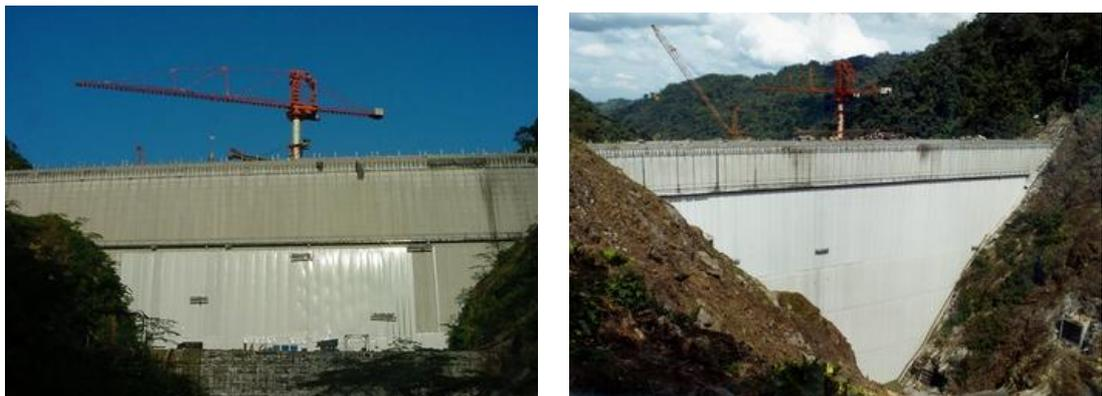
**FIGURA 2.32** Instalação de Manta de PVC na Face de Montante de Miel I
