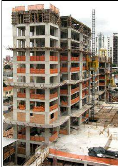
Figura 2.2: obra com utilização de sistema aporticado (TECNISA, 2009)
