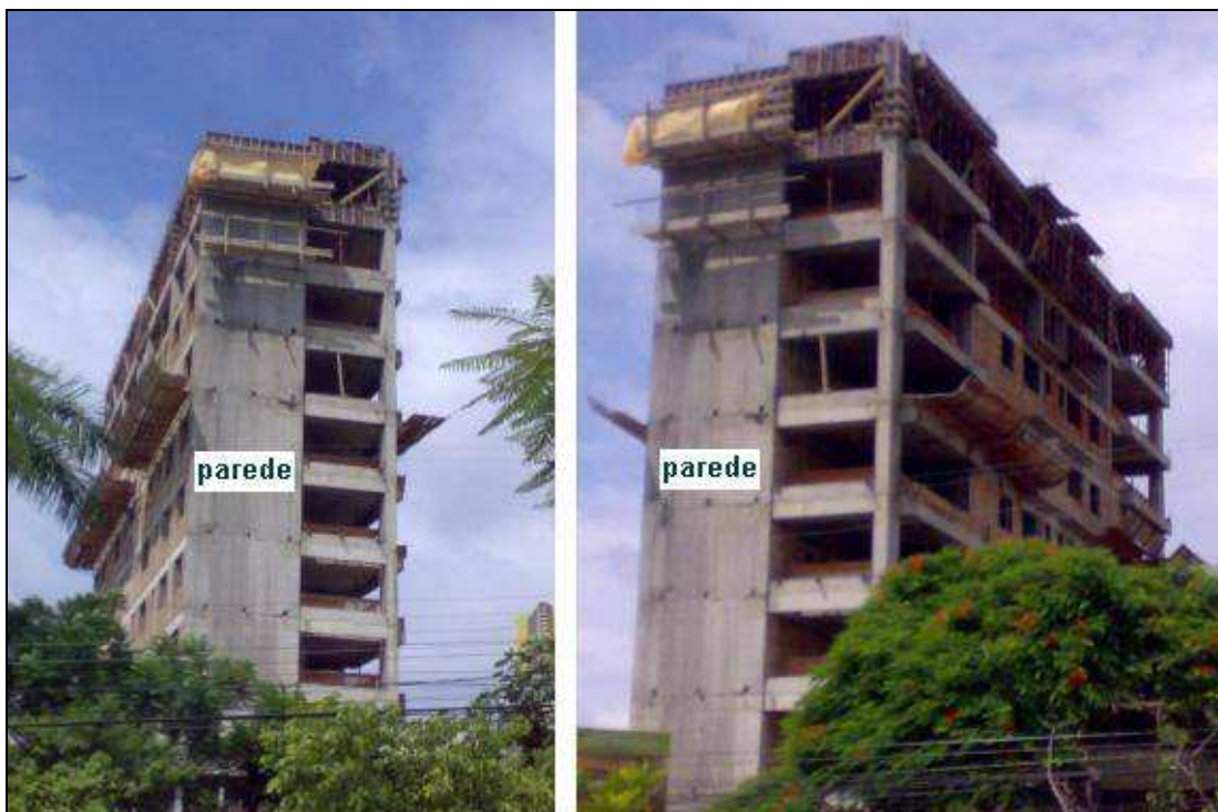
Figura 2.6: obra com inclusão de parede resistente no sistema aporticado
