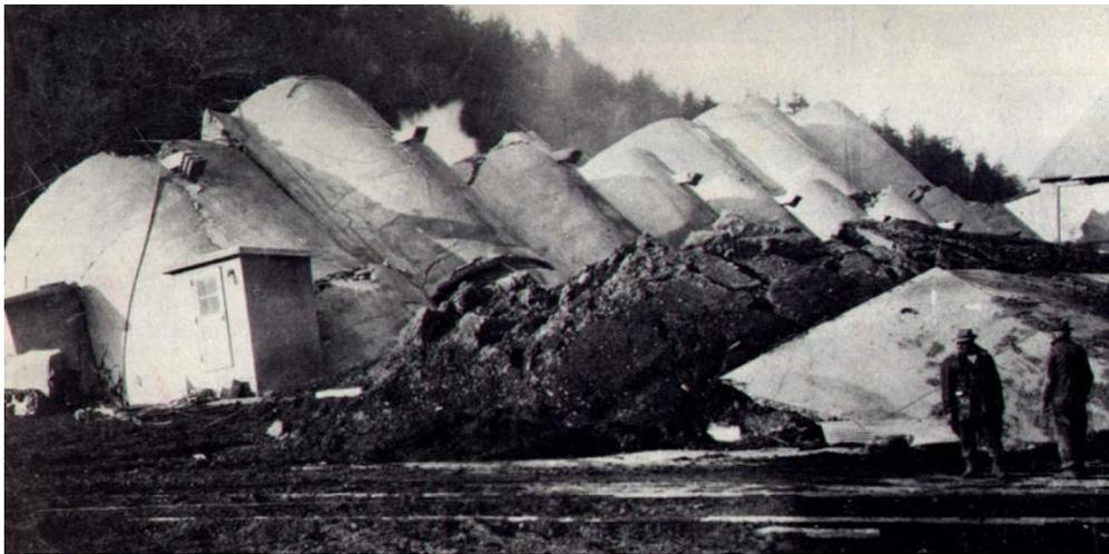
Figura 2.14 - Ruptura generalizada nas fundações de um silo de concreto armado (Tschebotarioff, 1978 apud CINTRA et al, 2011)
