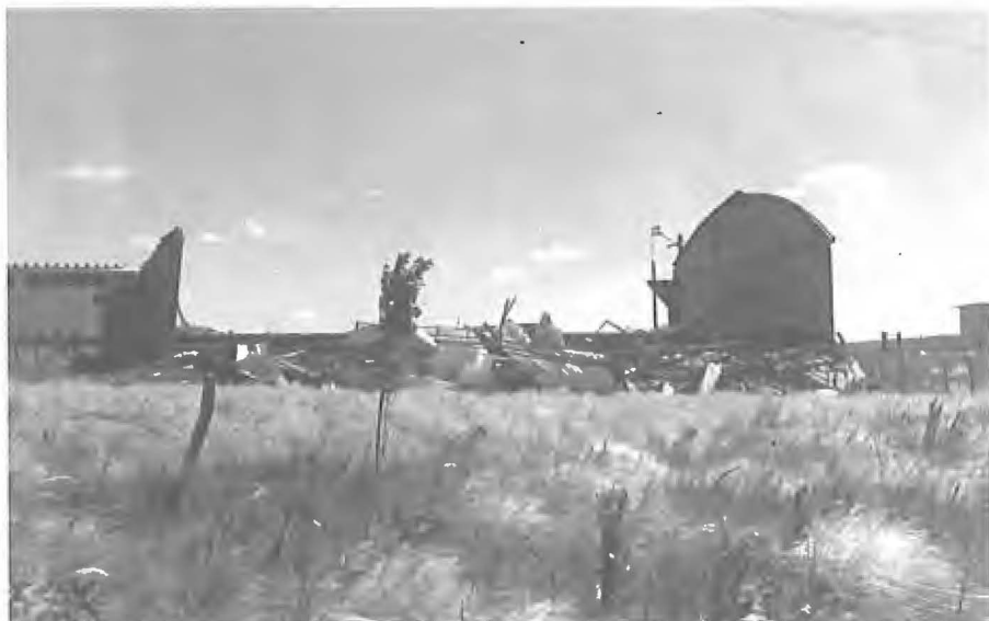
Figura 16 – Hangar em Carazinho, RS.
