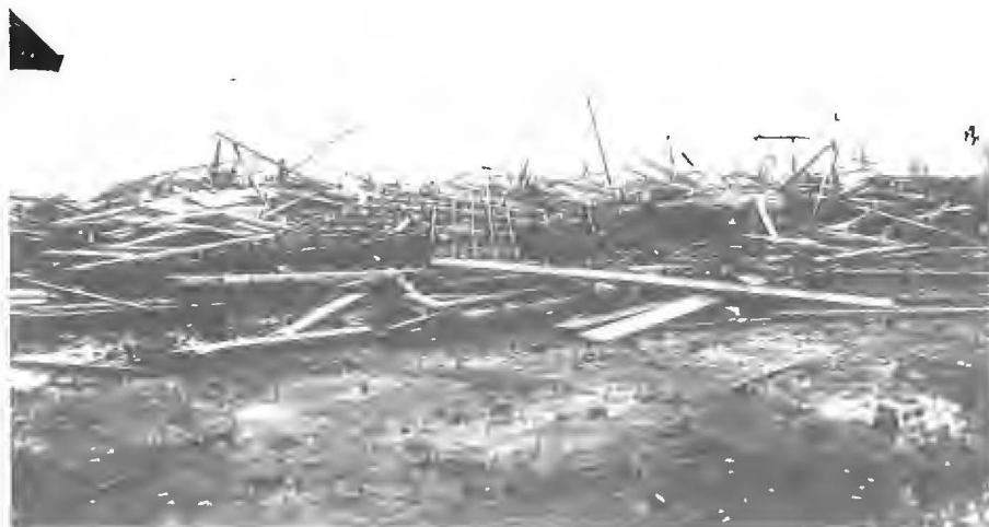
Figura 17d – Outros detalhes dos danos ocorridos em Lageado, RS.
