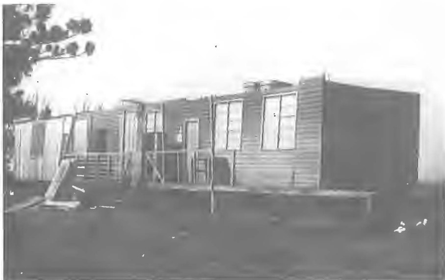
Figura 8a – Acampamento para construção de barragem em Santiago, RS.
