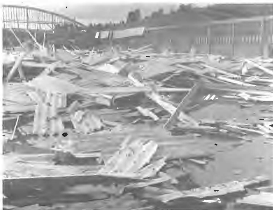
Figura 5b – Pavilhão da FENAC em Novo Hamburgo, RS.
