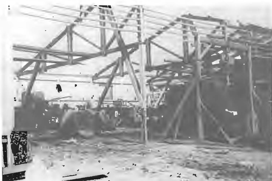
Figura 8b – Acampamento para construção de barragem em Santiago, RS.
