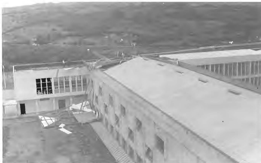
Figura 4 – Prédio nos arredores de Porto Alegre, RS.
