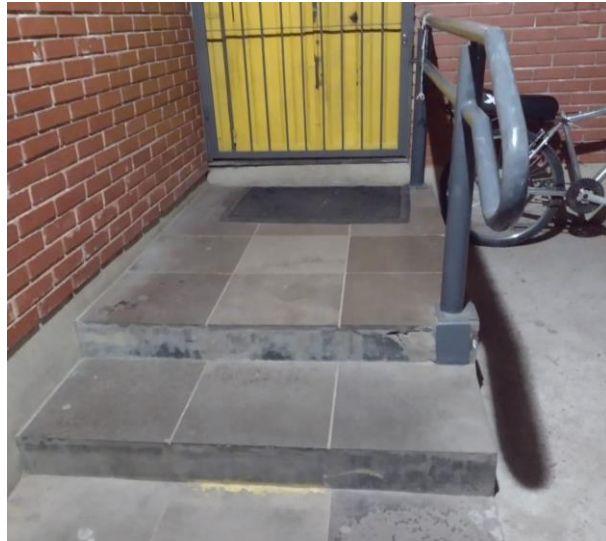
Figura 17 – Entrada bloco B
