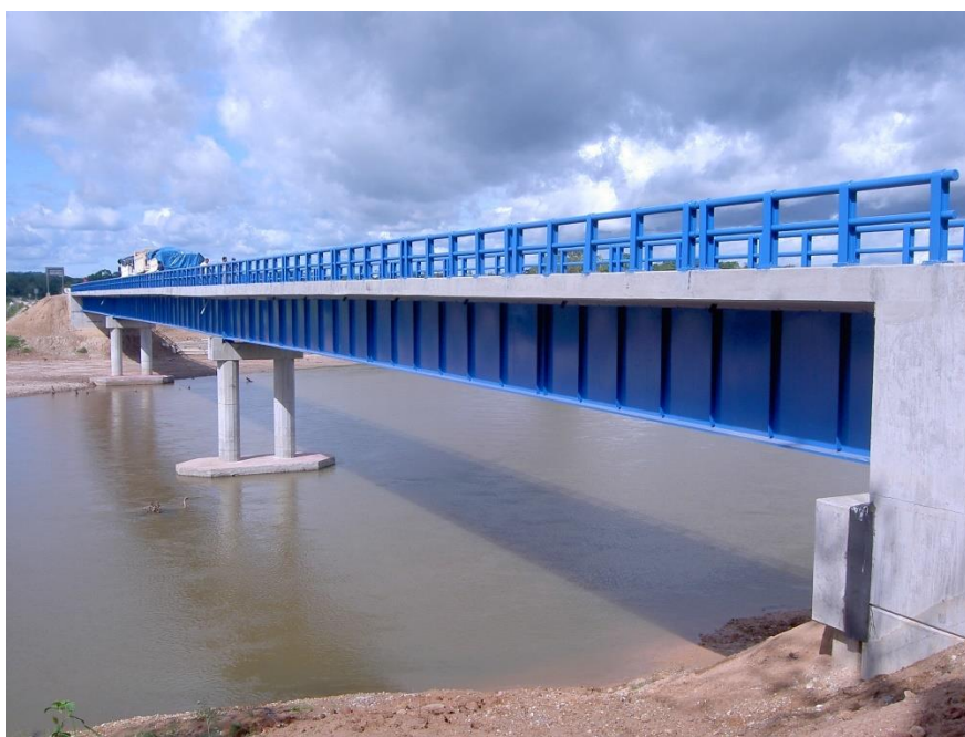
Figura 5-13 – Ponte Caynarachi – estrutura finalizada – Fonte: VSM Engenharia.
