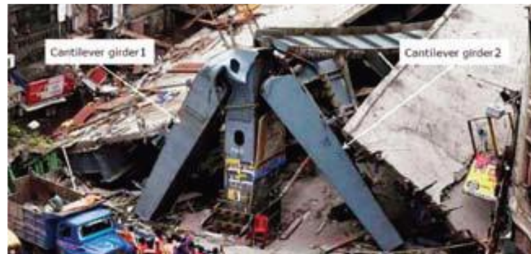
(c) Viaduto Kote, Índia (NARASINGARAO E NARAYANAN, 2017).
