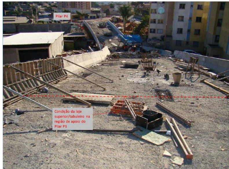
(b) Viaduto Batalha dos Guararapes, Brasil (CONSOL, 2014)
