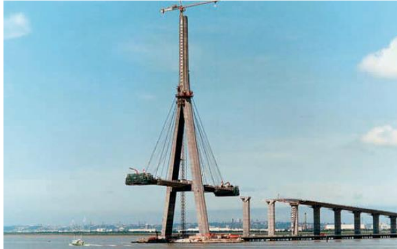
Figura 2-9 – Lançamento de aduela de concreto – Fonte: Svensson (2012).
