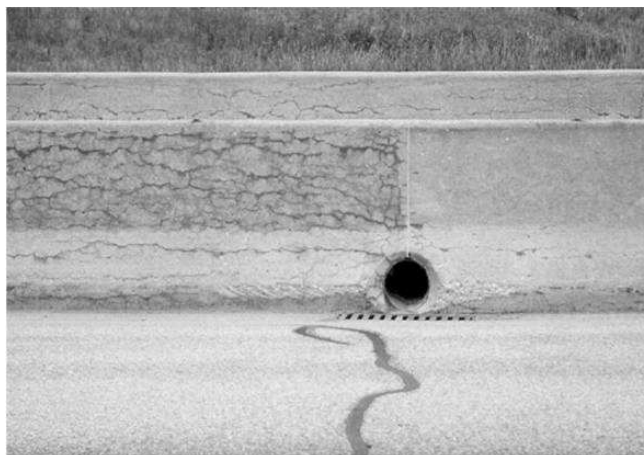
Figura 11: Parede em Quebec - a seção à direita do muro foi tratada com um selante à base de silano. (Fonte: Thomas et al, 2007)
