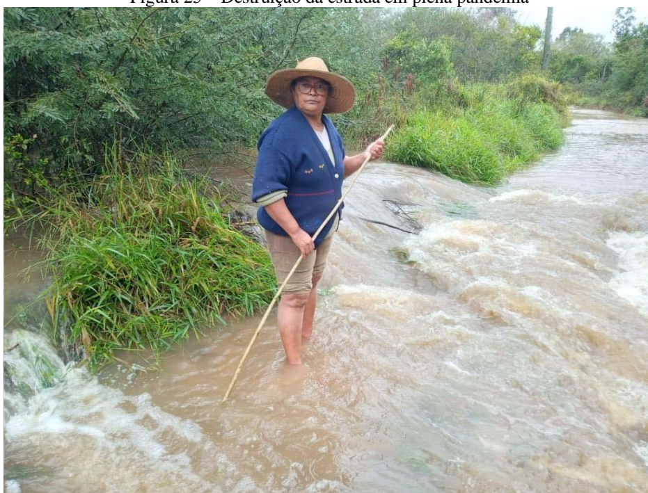
Figura 25 – Destruição da estrada em plena pandemia
