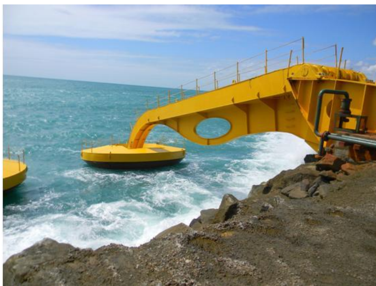
Figura 2.19 – Dispositivo conversor da energia das ondas do mar em energia elétrica [COPPE, 2015].
