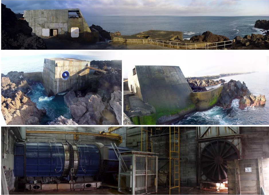
Figura 2.11 – Projeto de dispositivo 400 kW CAO da Ilha de Pico [Save Pico Powerplant, 2015].
