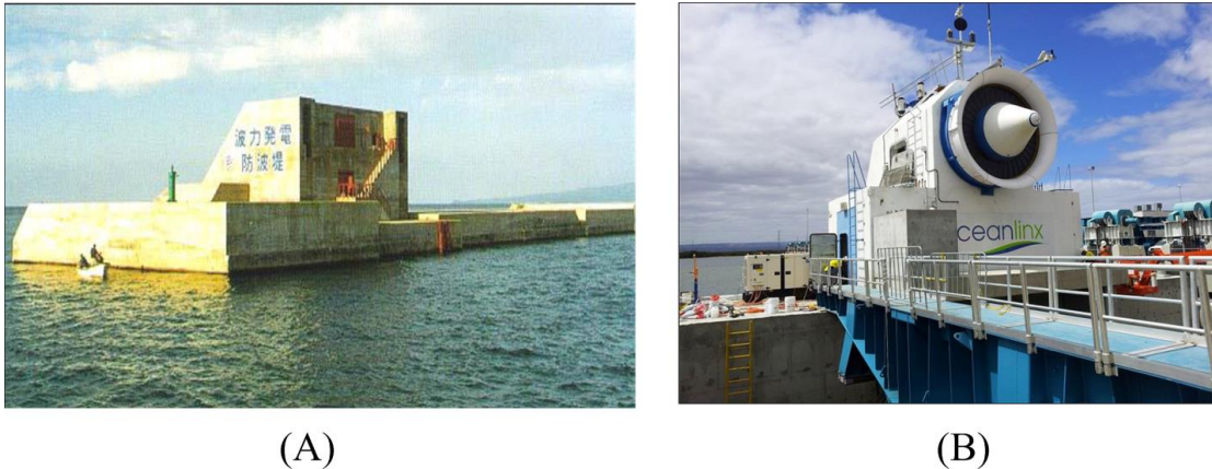
Figura 2.13 – (A) Dispositivo localizado na cidade de Sakata, Japão e (B) Dispositivo Oceanlinx construído no porto de MacDonnell, Austrália.
