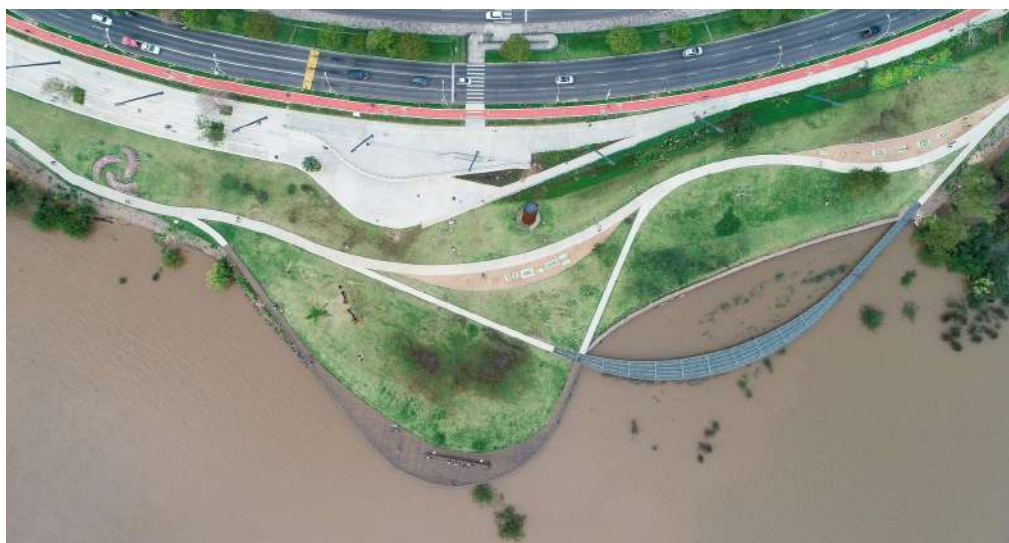
Figura 19 – Vista aérea parcial do Trecho 1 com obra Paisagem
