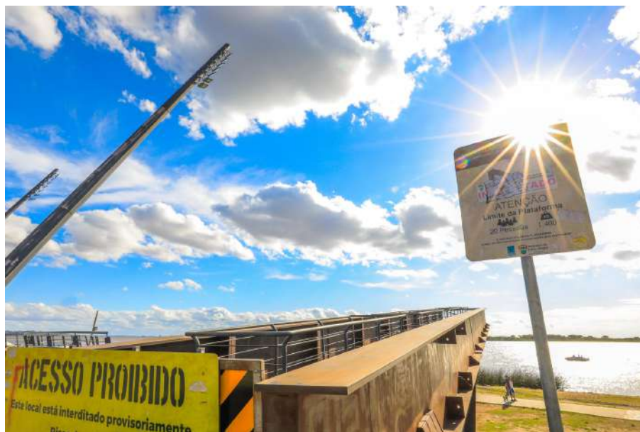
Figura 35 - Registro dos reparos na obra Olhos Atentos
