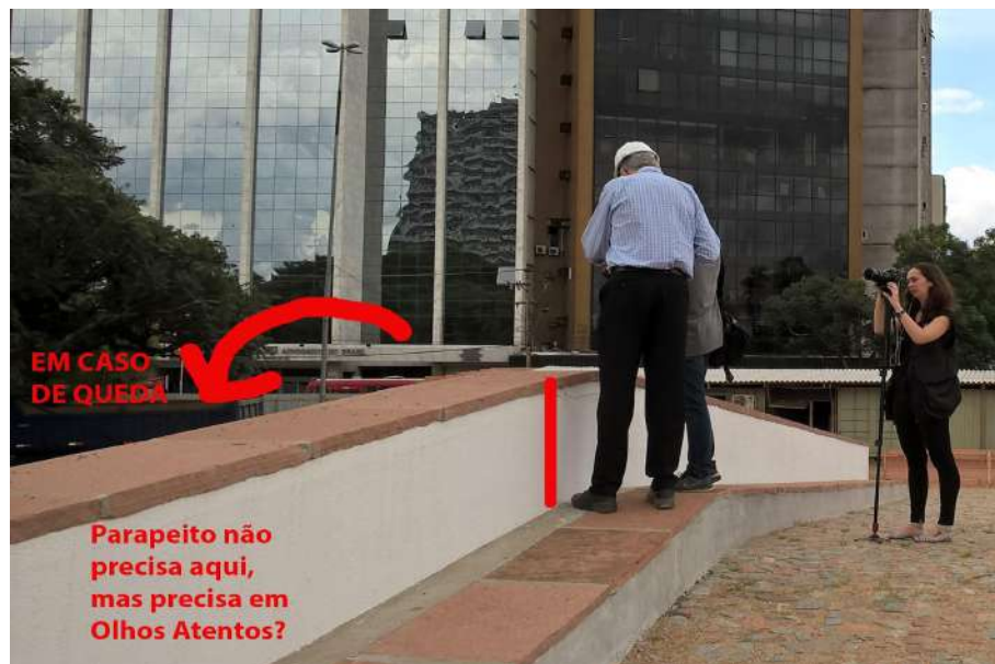
Figura 32 - Imagem para análise da altura da mureta na Ponte de Pedra
