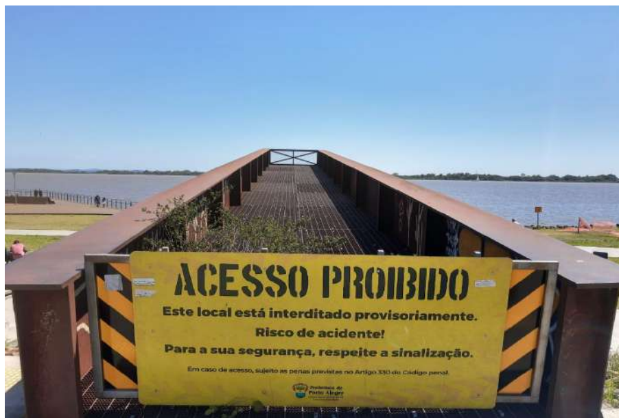
Figura 34 - Obra Olhos Atentos com placa de acesso proibido
