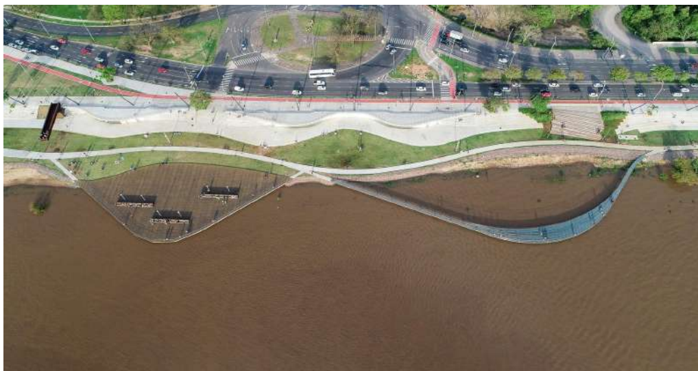
Figura 18 - Vista aérea parcial do Trecho 1 do Parque Urbano com obras Olhos Atentos e Cascata
