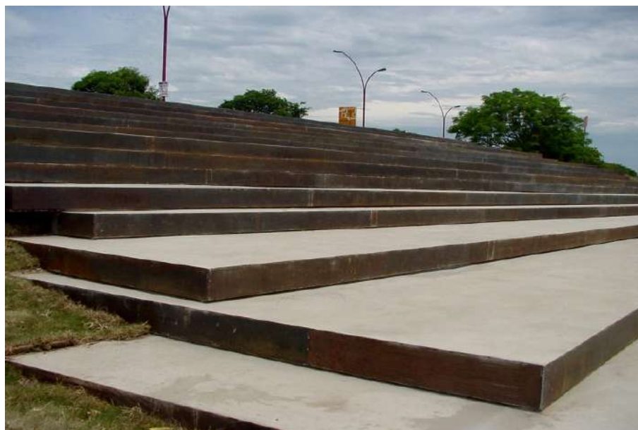
Figura 8 - Obra Cascata com destaque ao desnível dos degraus
