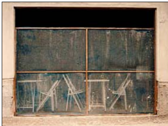
Figura 5.6 – Refeitório com isolamento em tela de náilon.
