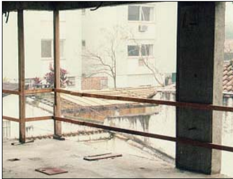
Figura 5.9 – Proteção periférica mais comumente encontrada.
