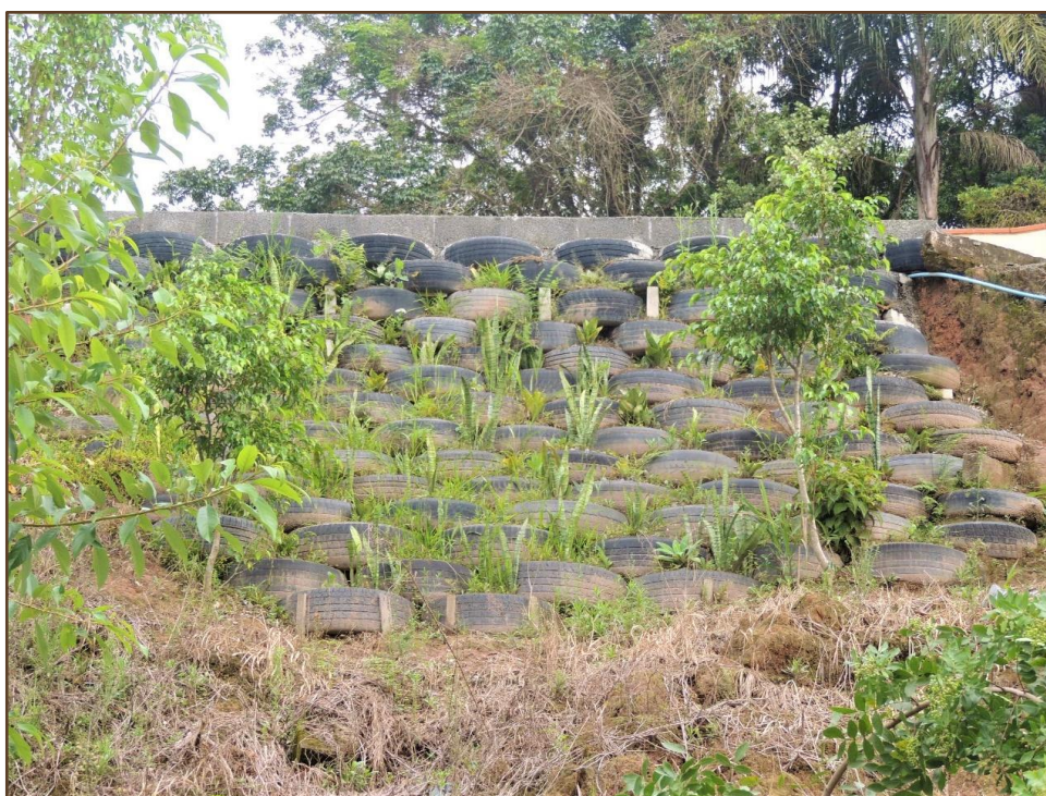
Figura 68: Uso de pneus na contenção da encosta no bairro Ponta Aguda.
