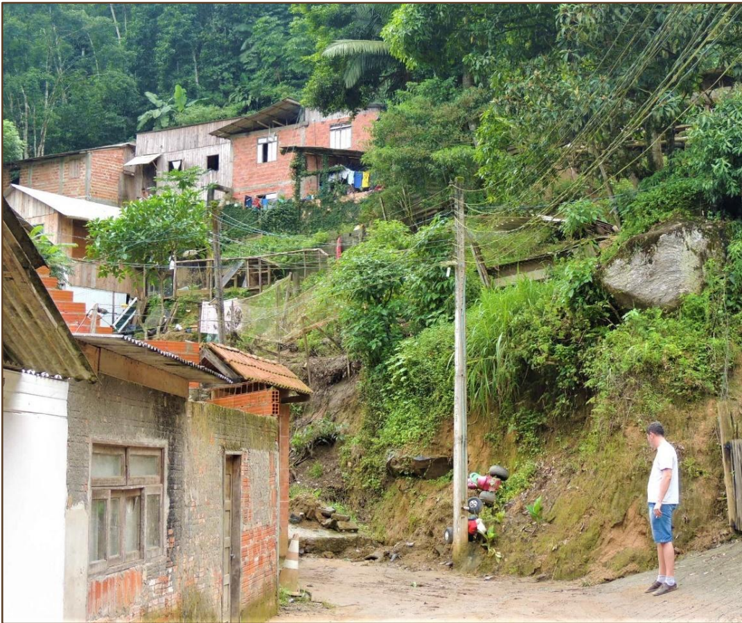
Figura 65: Blocos de rocha próximo a moradias no bairro Itoupava Central.
