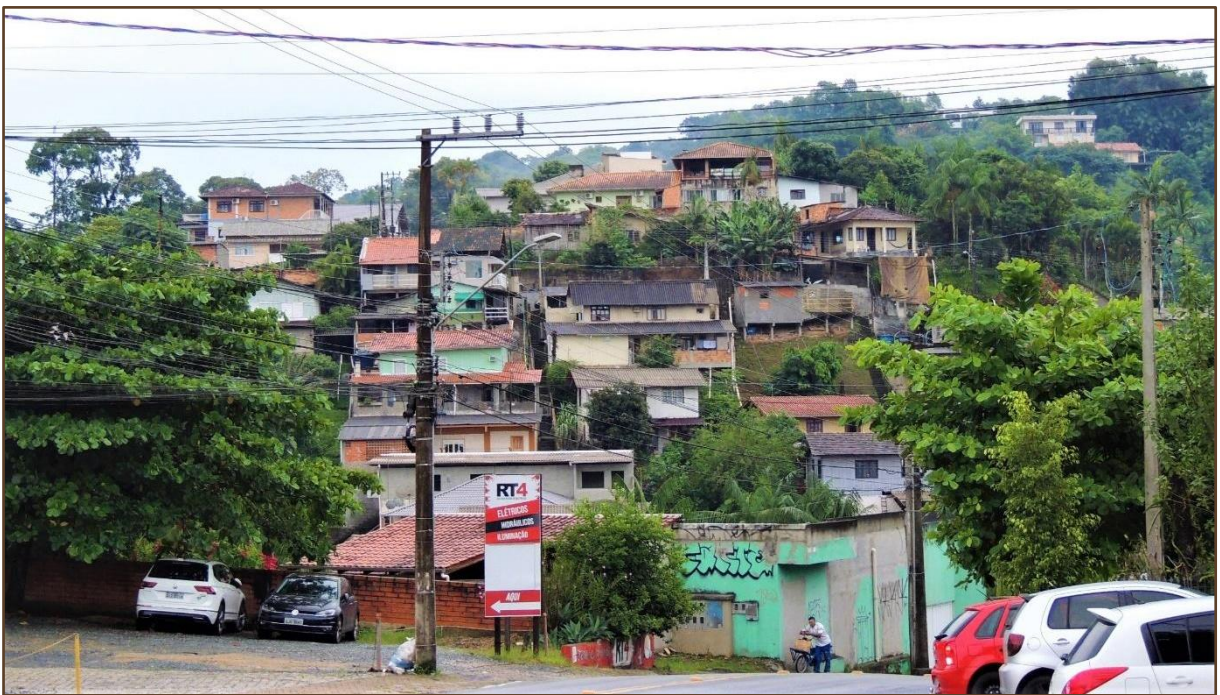
Figura 63: Moradias construídas em patamares com pilotis na porção norte de Blumenau.
