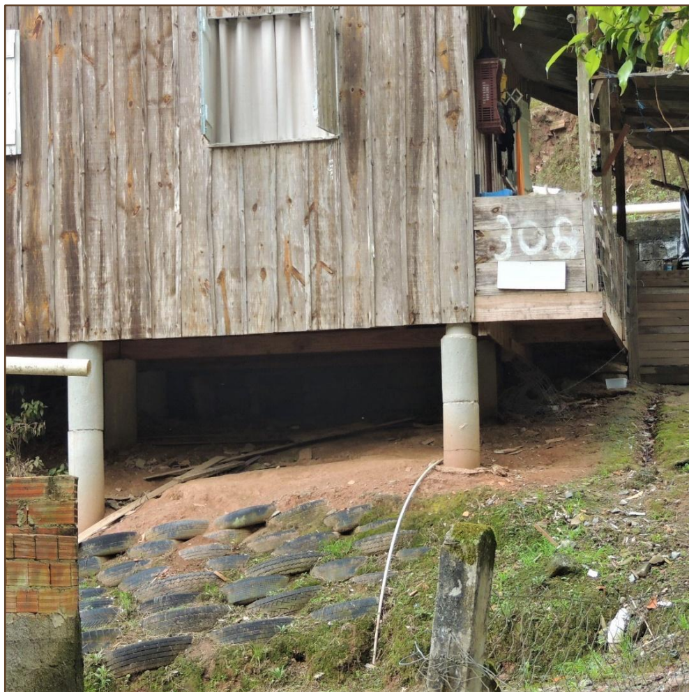
Figura 69: Uso de pneus e pilotis como solução individual no bairro Nova Esperança.
