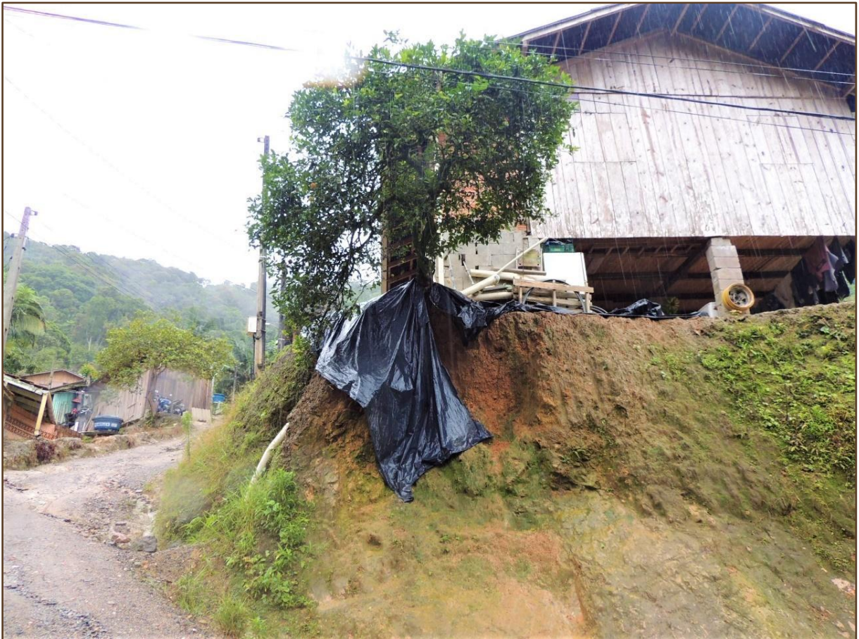
Figura 64: Cobertura da encosta em área fora do perímetro urbano situada no fundo do vale no bairro Progresso.
