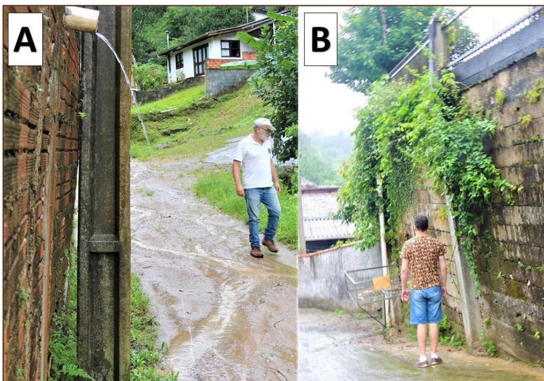
Figura 67: Drenagem deficiente promovendo a inclinação de muros no bairro Da Glória.
