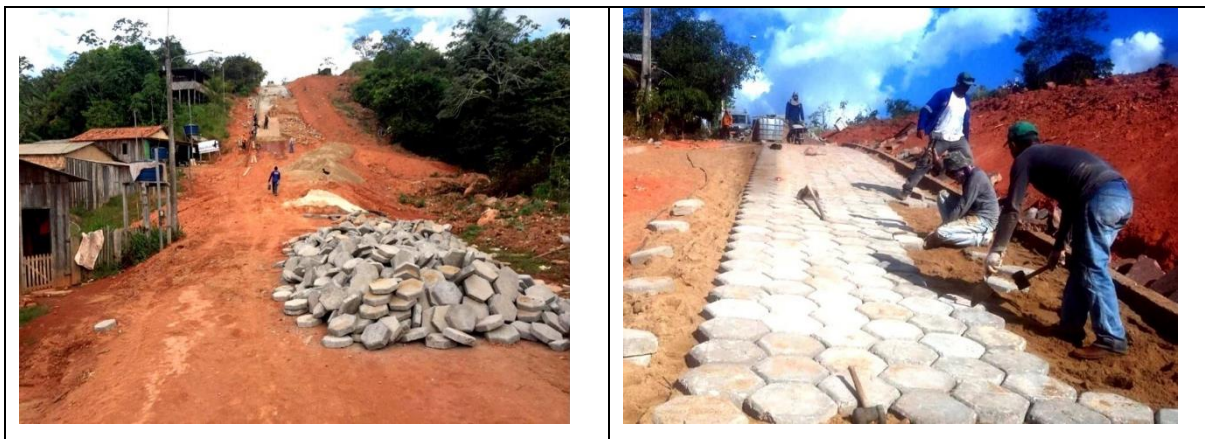
Figura 23. Pavimentação de Ruas na Vila Belo Monte Fonte: Prefeitura de Vitória do Xingu
