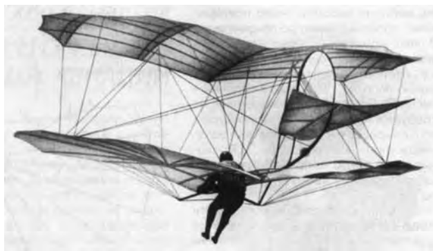
Figura I-15 – Planador biplano dos irmãos Lilienthal, com asas nitidamente encurvadas
