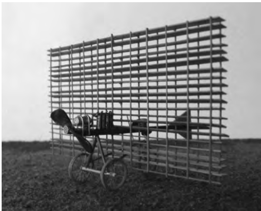
Figura 4.38 – Horatio Philips. Modelo motorizado, com 20 asas estreitas superpostas, 1904.
