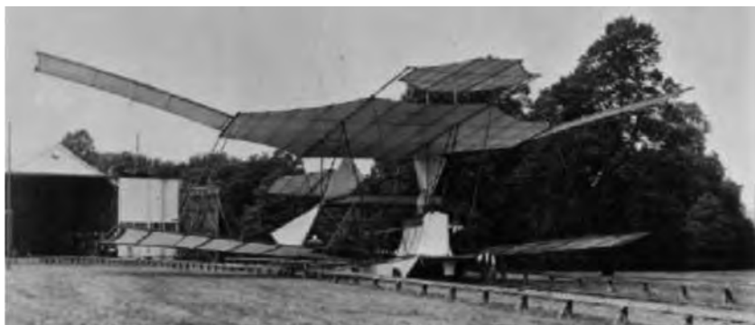
Figura 4.12 – Biplano de Maxim, com cerca de 32 m de envergadura e 33 m de comprimento.
