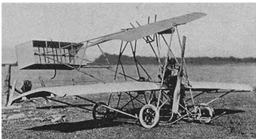
Figura 4.35 – Avião de Preston Watson. Motor a gasolina, refrigerado a ar, 1906.
