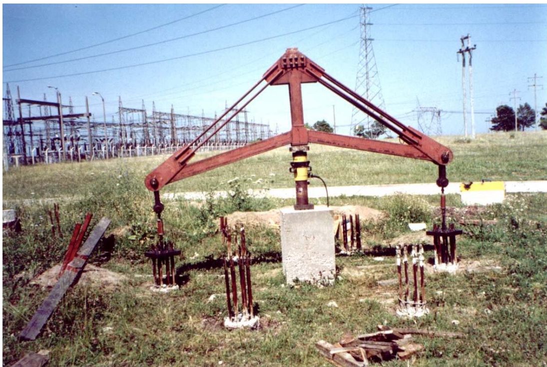
Figura 4.19 Montagem das provas de carga à tração
