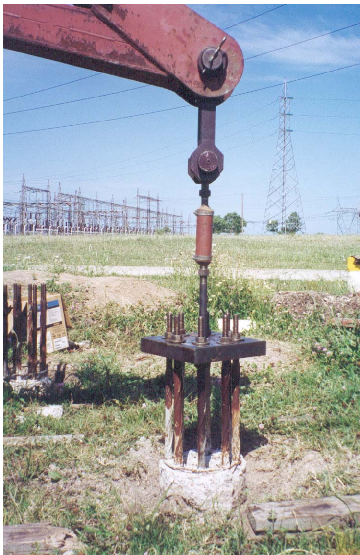
Figura 4.13 Elementos de ligação viga-estaca em posição na montagem (P19 a P34)
