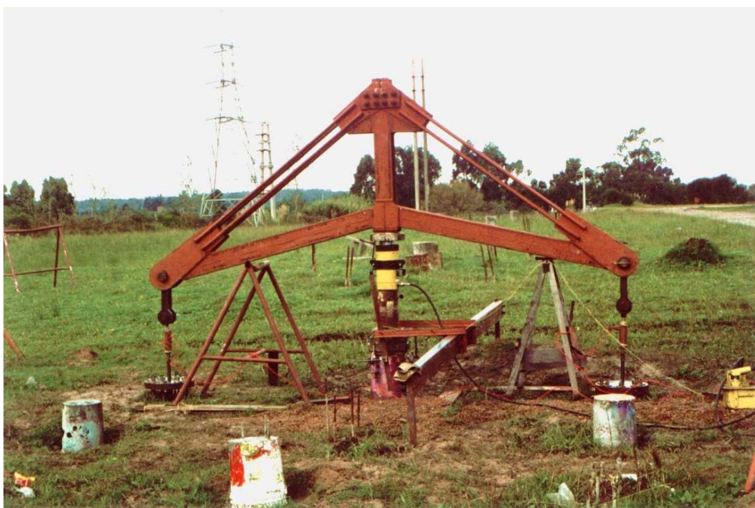
Figura 4.20 Montagem das provas de carga à compressão
