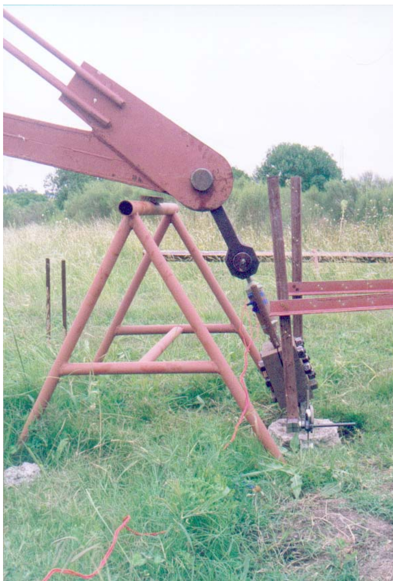
Figura 4.12 Elementos de ligação viga-estaca em posição na montagem (P13 a P18)
