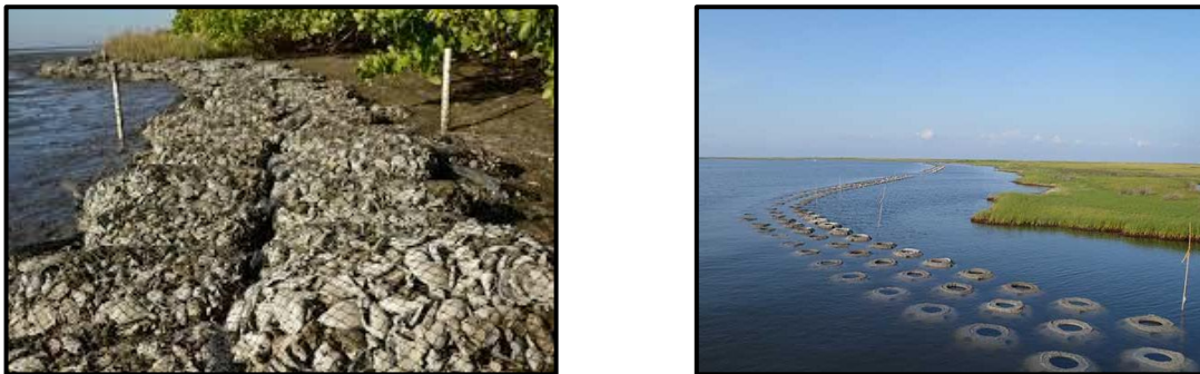
Figura 9: Conchas ensacadas e recifes artificiais de concreto. (Fonte: Kirkpatrick, 2013)
