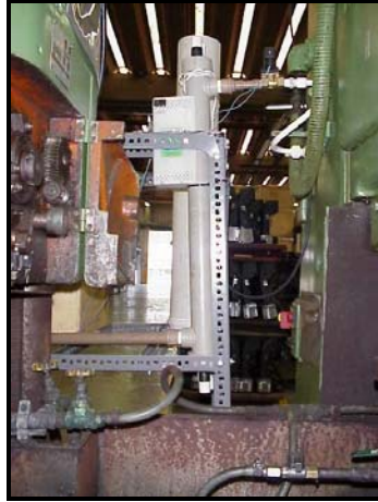
Figura 4.6: Sistema de esterilização da água por radiação ultravioleta.
