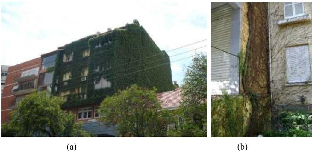
Figura 33: Pele-verde da espécie *Parthenocissus tricuspidata* em edificação estudada com aproximadamente 25m de altura, onde apenas uma muda é responsável por todo o revestimento – vista geral (a) e detalhe da ligação entre a trepadeira e o solo (b).
