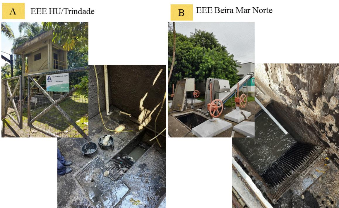
**Figura 5 – Vista Externa e dos Gradeamentos das Unidades Operacionais de estudo: (A) EEE HU/Trindade – SB6; (B) EEE Beira-mar - A.**
