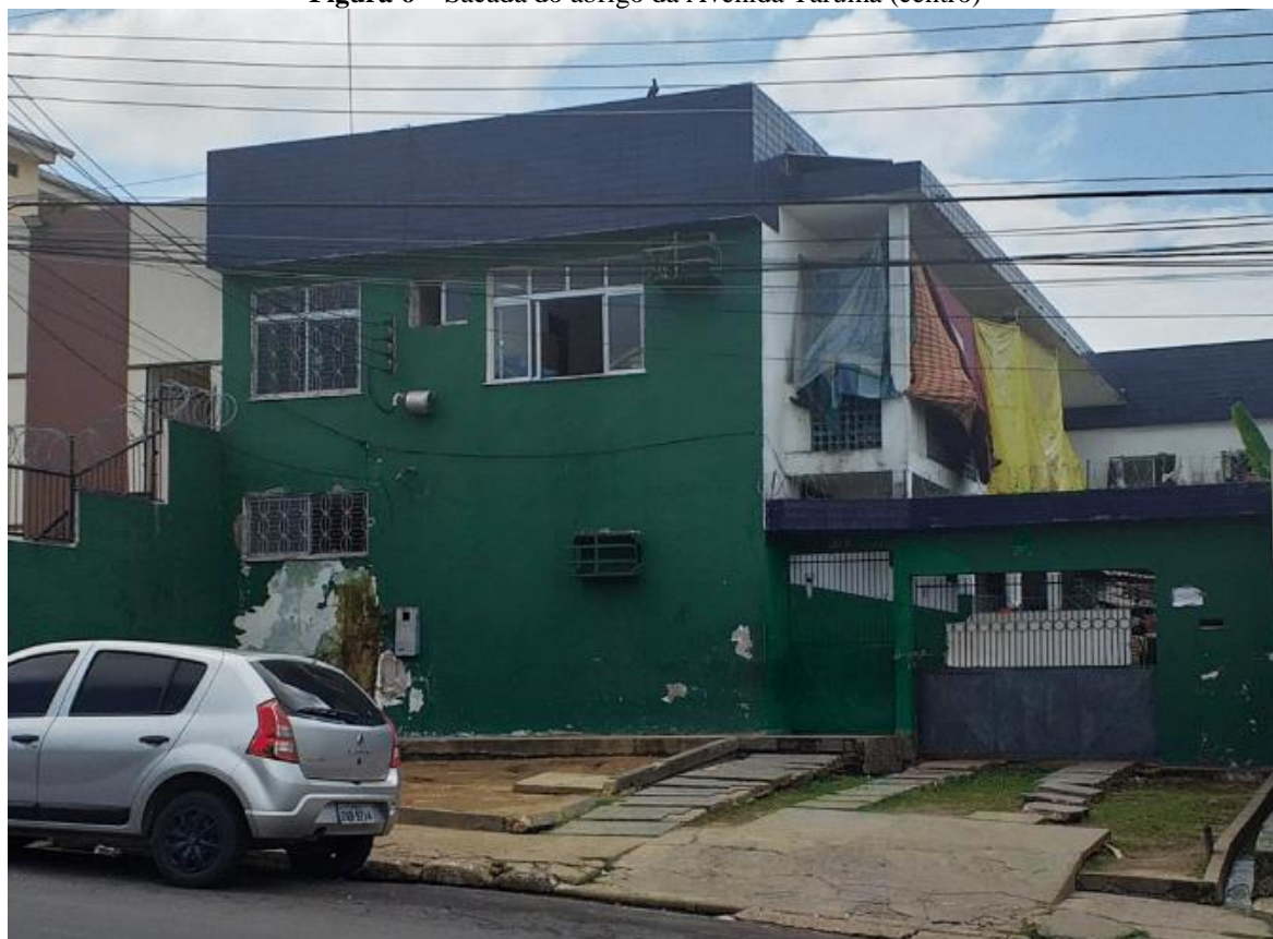
Figura 6 – Sacada do abrigo da Avenida Tarumã (centro)
