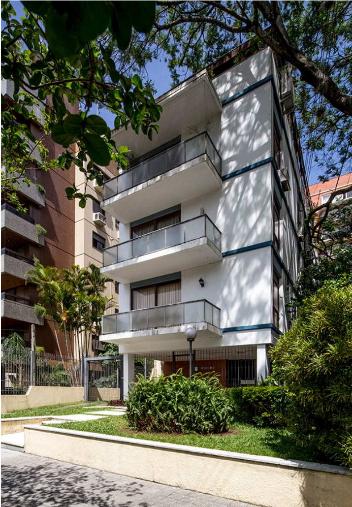
Figura 63 - Edifício Novo Parque. Fonte: VIEIRA, 2021.
