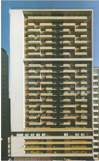
Figura 7 - Edifício Jaguaribe. Fonte: ALMEIDA, 2010.
