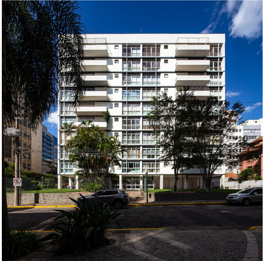
Figura 49 - Edifício Christoffel. Fonte: VIEIRA, 2021.
