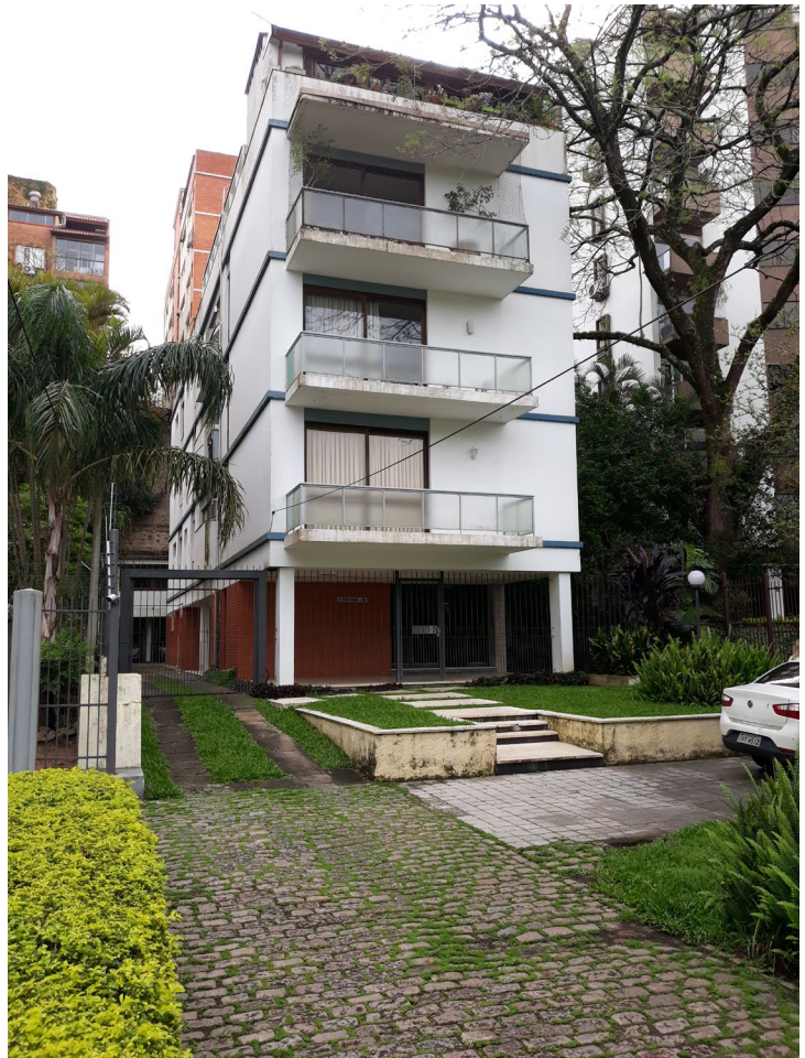
Figura 56 - Edifício Novo Parque. Fonte: VIEIRA, 2021.
