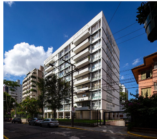
Figura 53 - Edifício Christoffel. Fonte: VIEIRA, 2021.
