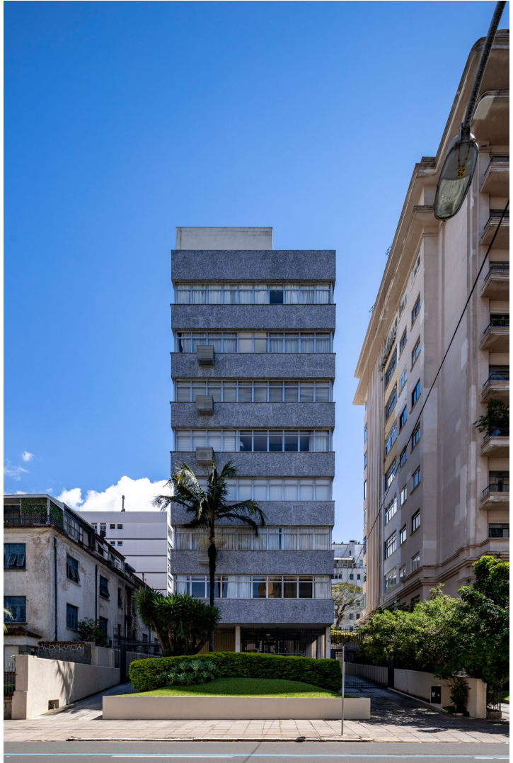
Figura 65 - Edifício Sinuelo. Fonte: VIEIRA, 2021.
