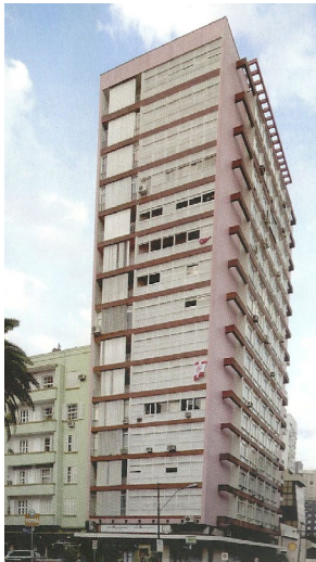
Figura 10 - Edifício Redenção. Fonte: VIEIRA, 2021.
