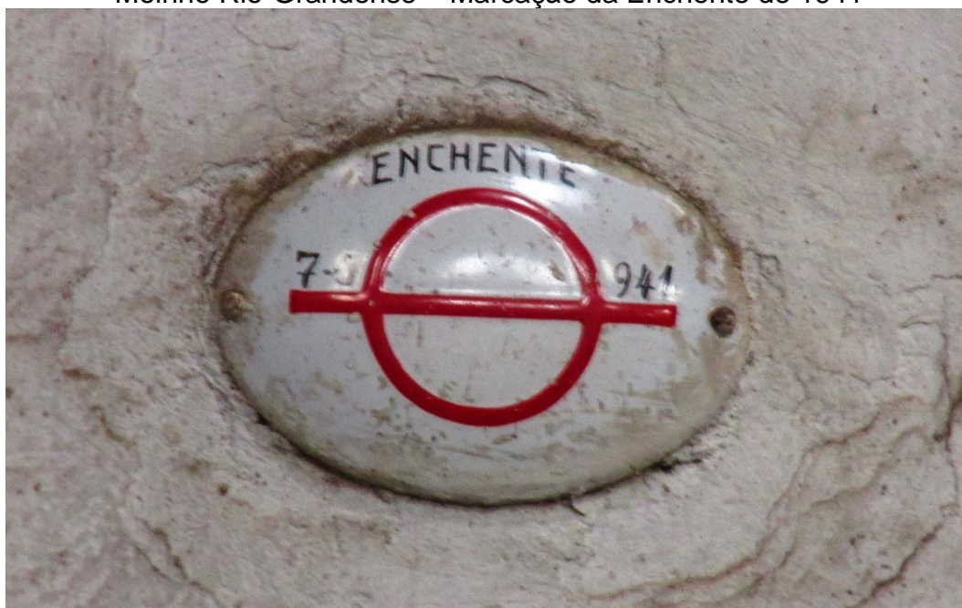
Figura 75 Moinho Rio-Grandense – Marcação da Enchente de 1941
