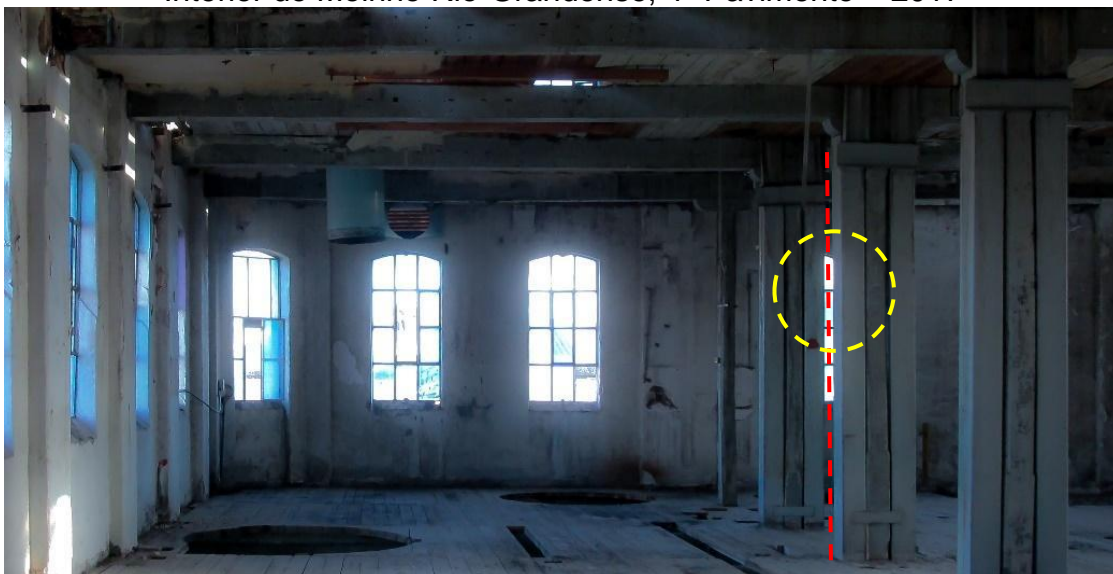
Figura 59 Interior do Moinho Rio-Grandense, 4º Pavimento – 2017
