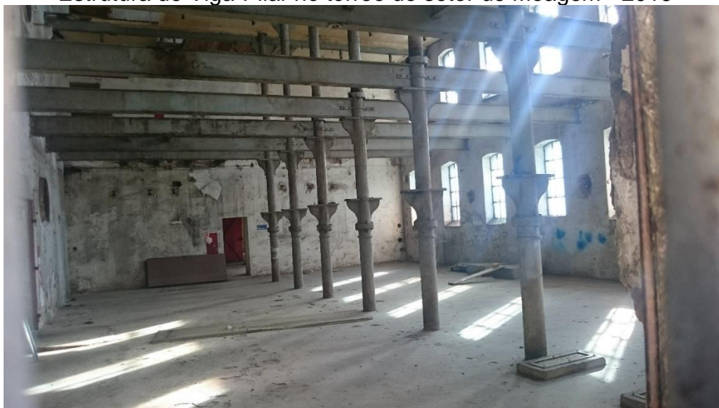
Figura 54 Estrutura de Viga-Pilar no térreo do setor de Moagem - 2016
