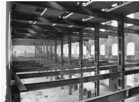
Figura 66 Imagem Interna Moinho Marconetti antes da intervenção
