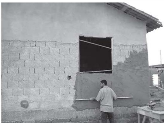
Figura 28 – Execução de revestimento
