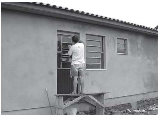
Figura 29 – Vista de aberturas e colocação de vidros
