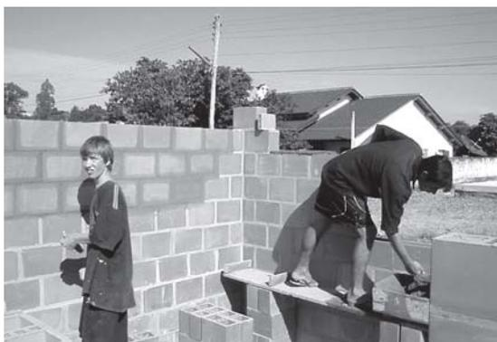
Figura 16 – Execução das alvenarias
