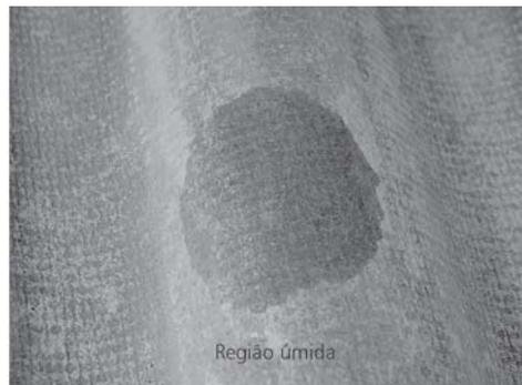
Figura 10 - Mancha na superfície inferior da telha de fibrocimento sem amianto, causada pela passagem de água
