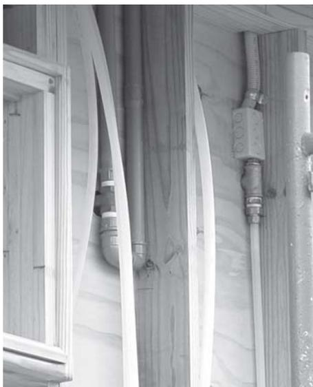
Figura 43: Colocação dos tubos PEX
