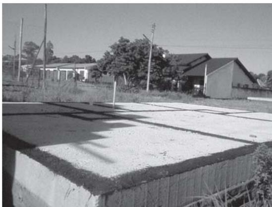
Figura 14 – Impermeabilização das vigas de fundação
