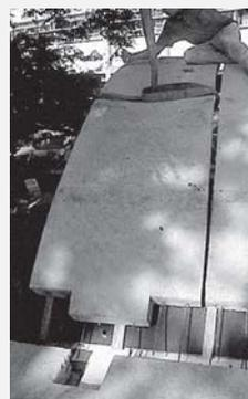
16 Painel-laje sendo içado e posicionado
