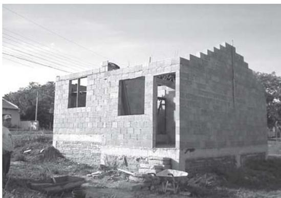
Figura 21 – Término das alvenarias – casa em desnível
