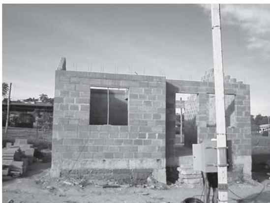
Figura 22 – Término das alvenarias – casa de dois dormitórios
