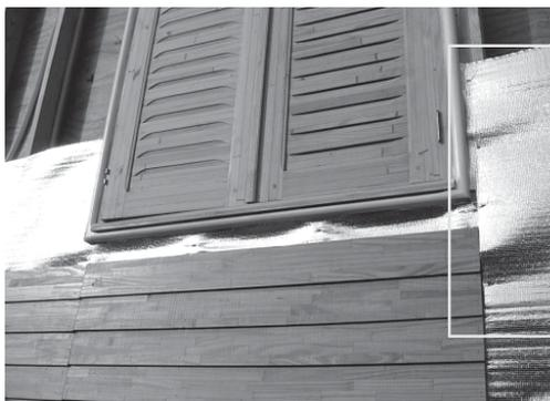
Figura 14: Corte nas tábuas de siding
