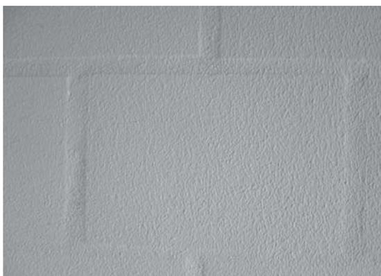
Figura 34 – Revestimento interno de textura sobre o bloco
