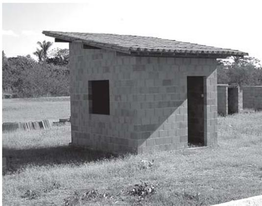
Figura 23 – Módulo executado com coberta de telha cerâmica
