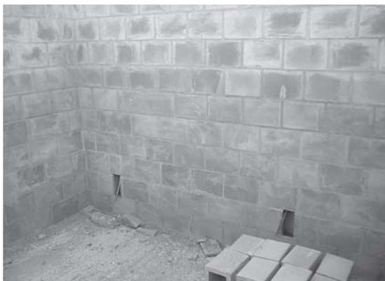
Figura 17 – Detalhe do bloco para caixa de luz
