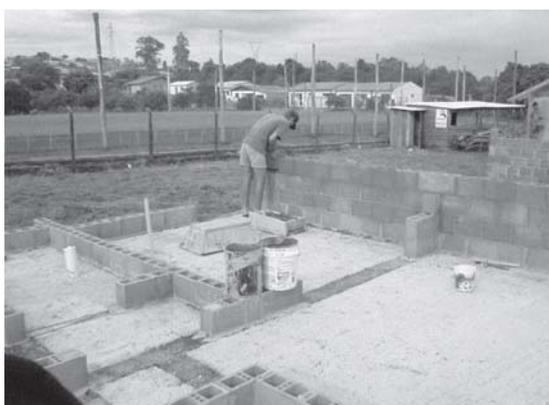
Figura 15 – Alvenarias – destaque da 1ª fiada
