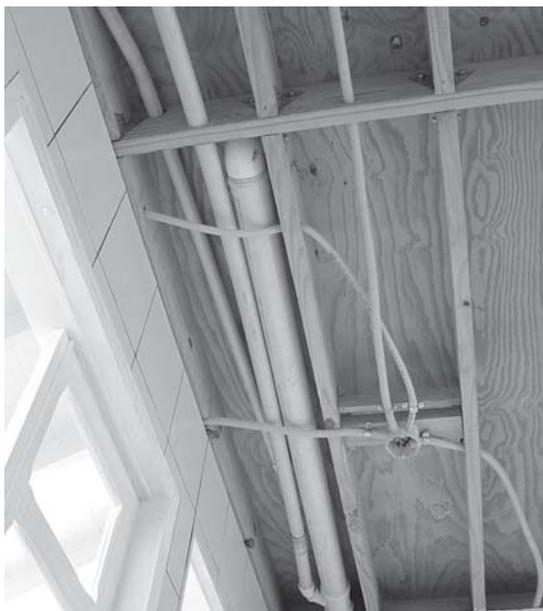
Figura 46: Tubulação de esgoto na laje de entrepiso
