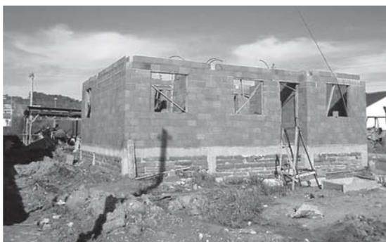
Figura 24 – Término das alvenarias – casa de quatro dormitórios
