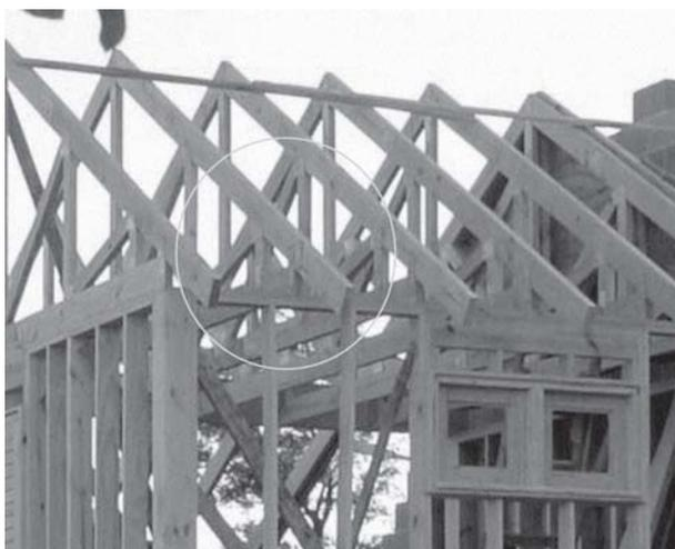
Figura 31: Falta de alinhamento com montantes da ossatura
