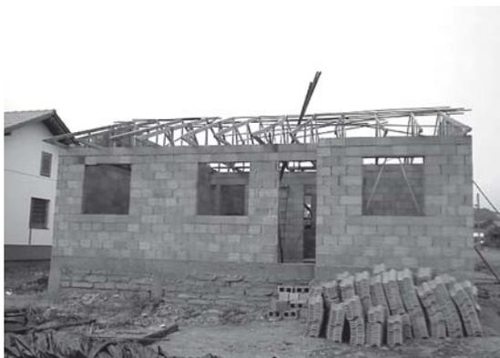
Figura 26 – Montagem da estrutura do telhado
