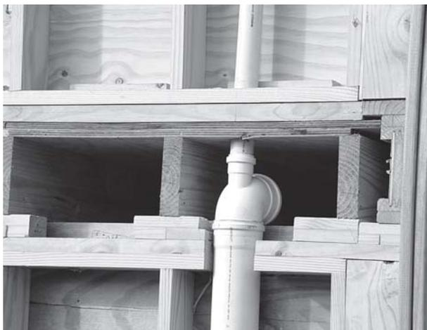
Figura 45: Ventilação do esgoto
