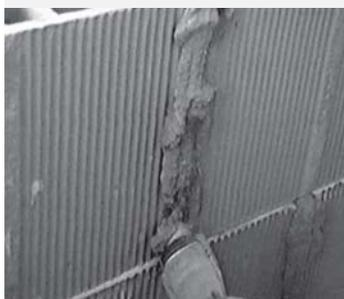
Figura 20 – Preenchimento das juntas verticais com bisnaga
