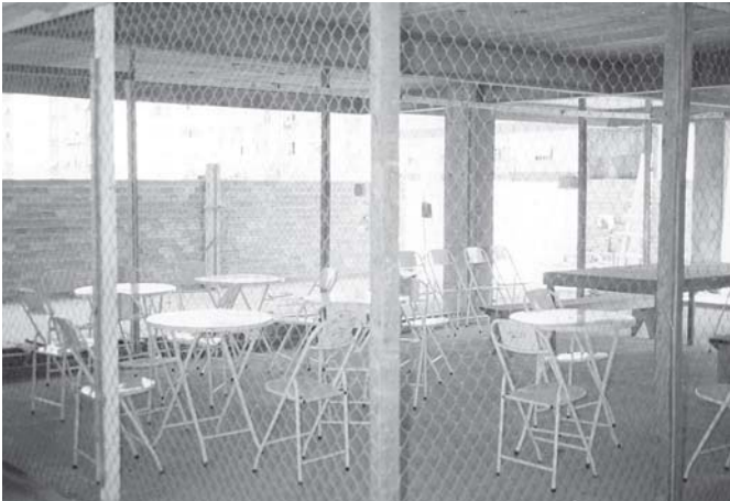
Figura 4.3 - Exemplo de fechamento e mesas para refeitórios em canteiros
