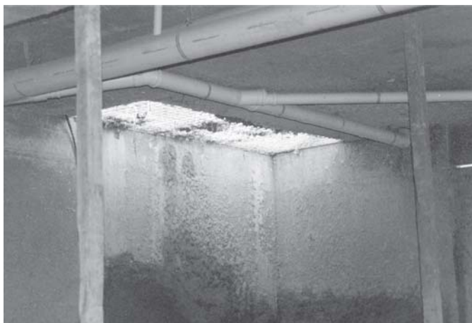
Figura 4.7 - Descarga de agregados através de abertura na laje do subsolo
