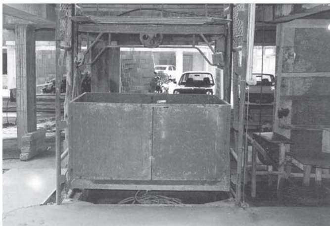
Figura 4.16 - Exemplo de elevador de carga - cobertura, porta e contenções laterais
