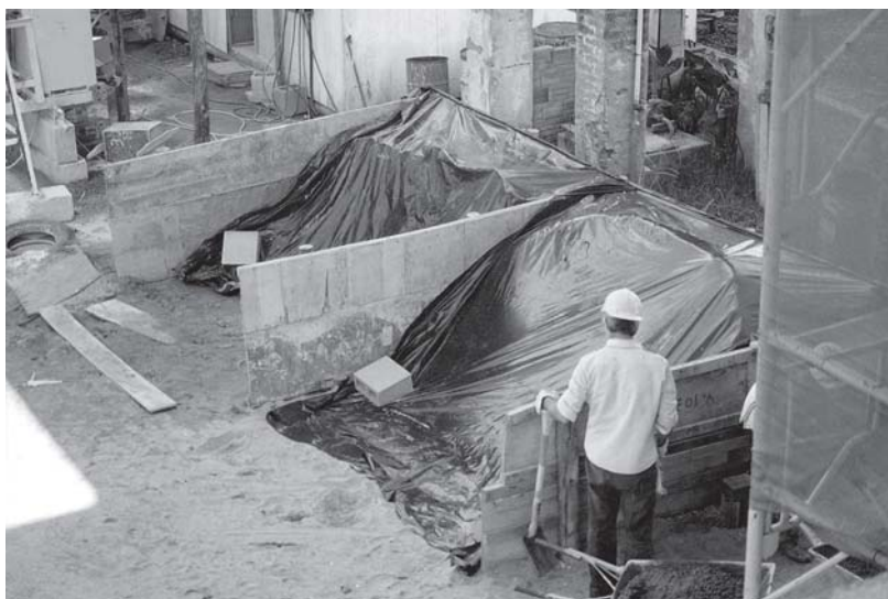
Figura 4.12 - Contenções laterais e lona de cobertura em baia de agregados
