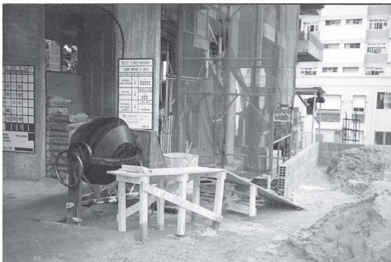
Figura 4.9 - Rampa para dosagem com carrinho dosador
