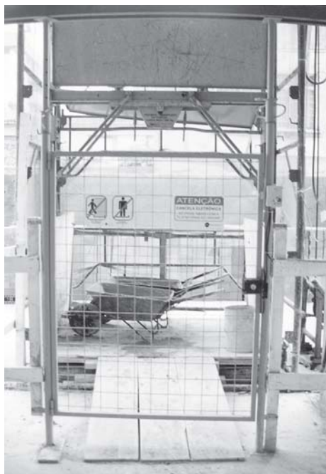
Figura 4.17 - Cancela de acesso à plataforma do elevador
