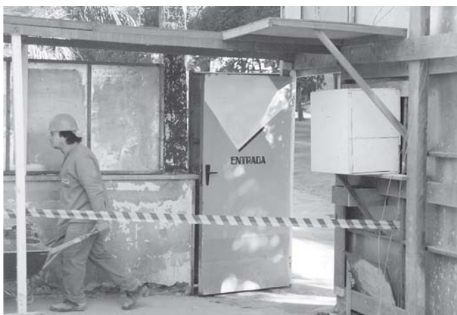
Figura 4.6 - Acesso coberto para entrada de pessoas na obra
