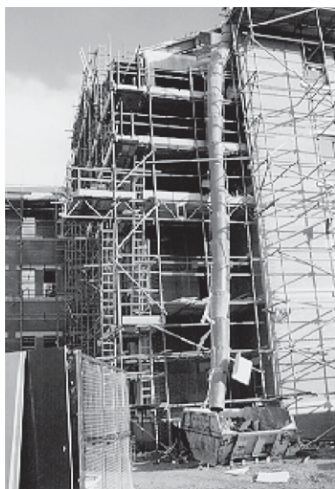
Figura 4.11 - Descarga de entulho com tubo coletor e disposição em caçamba basculante
