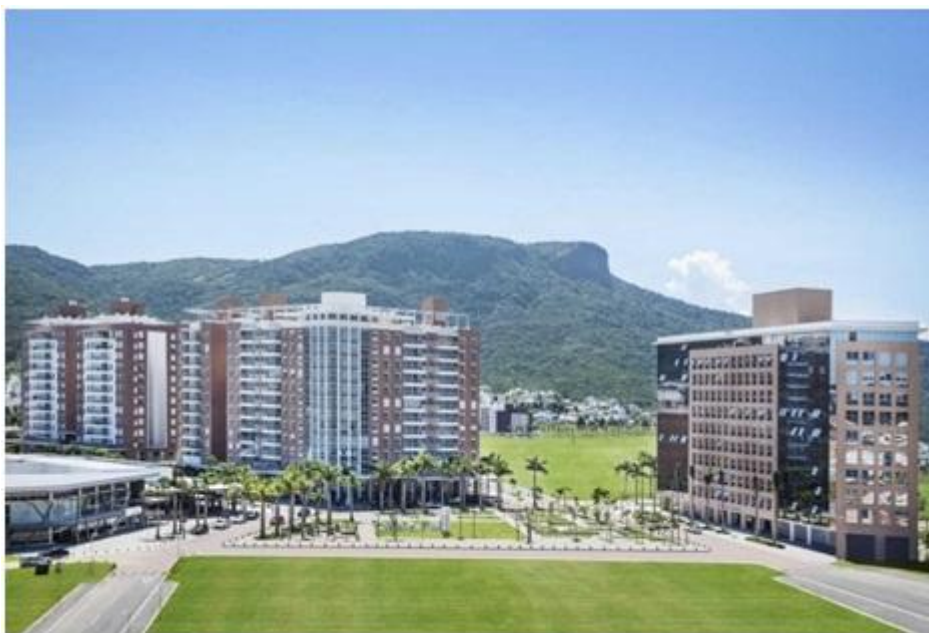
Figura 17: Núcleo Central - Bairro Pedra Branca
