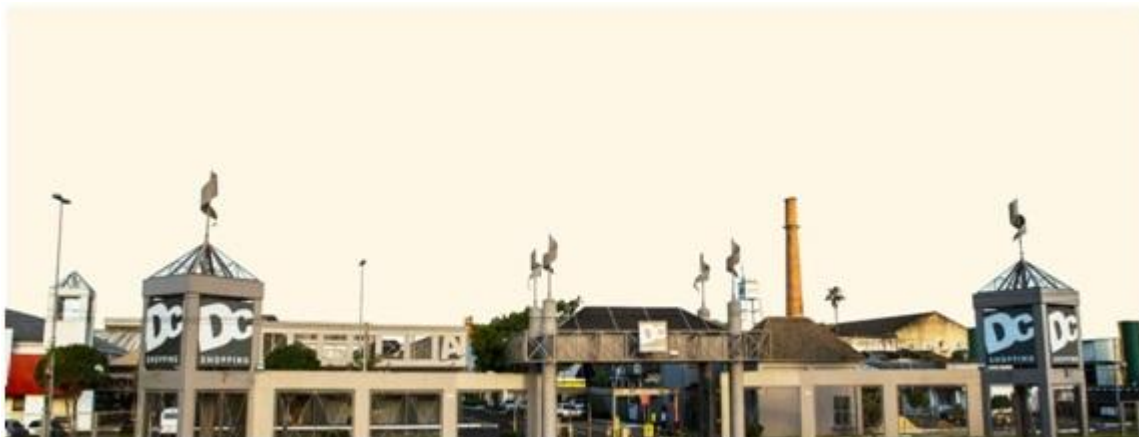
Figura 12: Pórtico de entrada Shopping DC Navegantes e outras reabilitações
