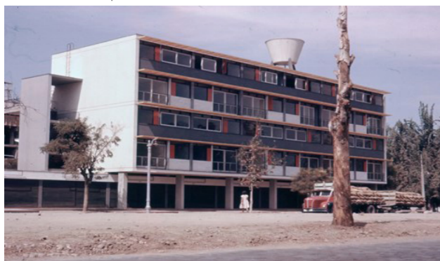
Figura 25: Fachada para a Av. Matta. Fonte: https://vimeo.com/199728207
