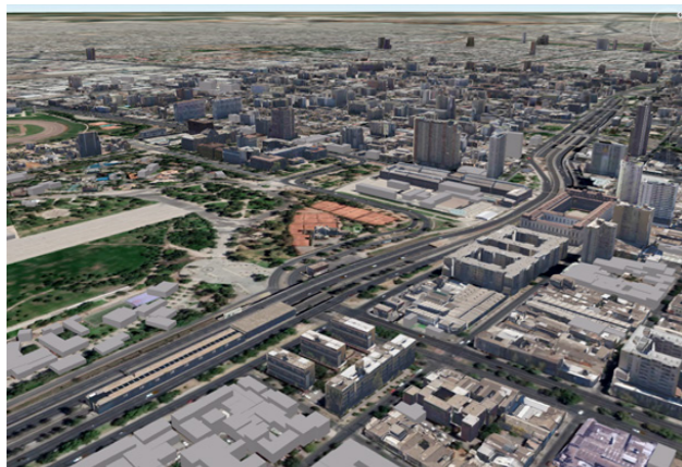
Figura 21: Conjunto Matta Viel e seu contexto urbano atual. Fonte Google earth, 2020.
