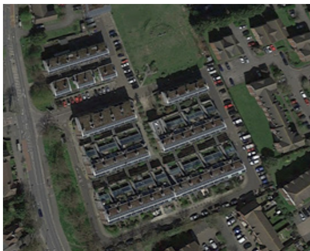
Figura 10: Imagem aérea do conjunto habitacional de uso misto BedZED, Londres, 2002. Fonte: Google Earth, 2019.
