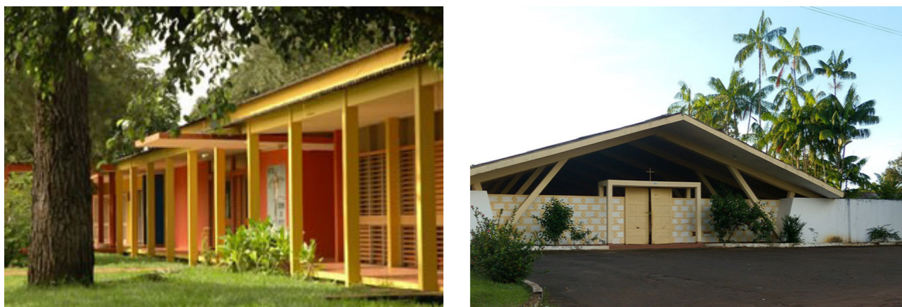
Figura 26: Habitações e edifícios públicos e comunitário do projeto de Vila Serra do Navio, Arq. Osvaldo Arthur Bratke (1950/1960). Patrimônio cultural desde 2010. Fonte: http://portal.iphan.gov.br/ap/noticias/detalhes/5517/iphan-realiza-entrega-de-titulos-fundiarios-na-vila-de-serra-do-navio-ap
