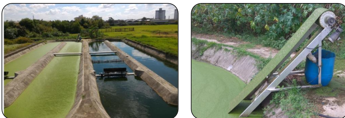
Figura 4. Unidades piloto de lagoas (esquerda) e sistema de retirada da macrófita (direita).
