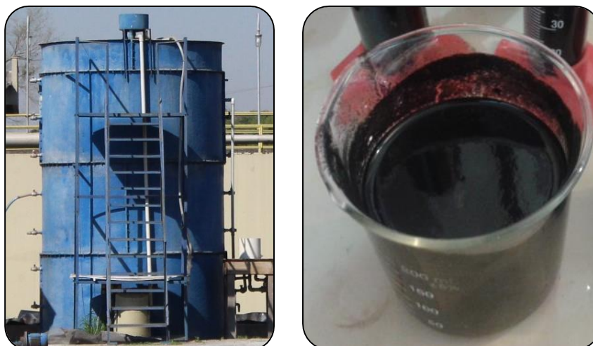
Figura 7. Reator UASB e lodo anaeróbio utilizado como inóculo.
