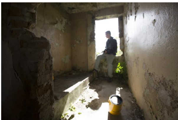
Figura 92: Uma das celas do Instituto Central de Menores em ruínas, março de 2019*
