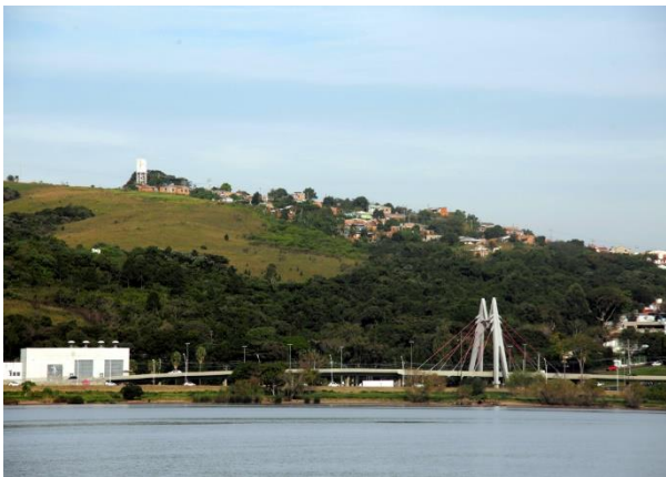
Figura 113: Vista do Morro Santa Tereza: a Caixa d'água da Vila Ecológica*
