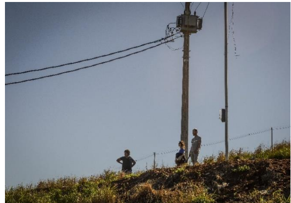
Figura 53: Rede de alta tensão no topo do Morro Santa Tereza para conectar aos relógios individualizados (canto direito da foto)*
