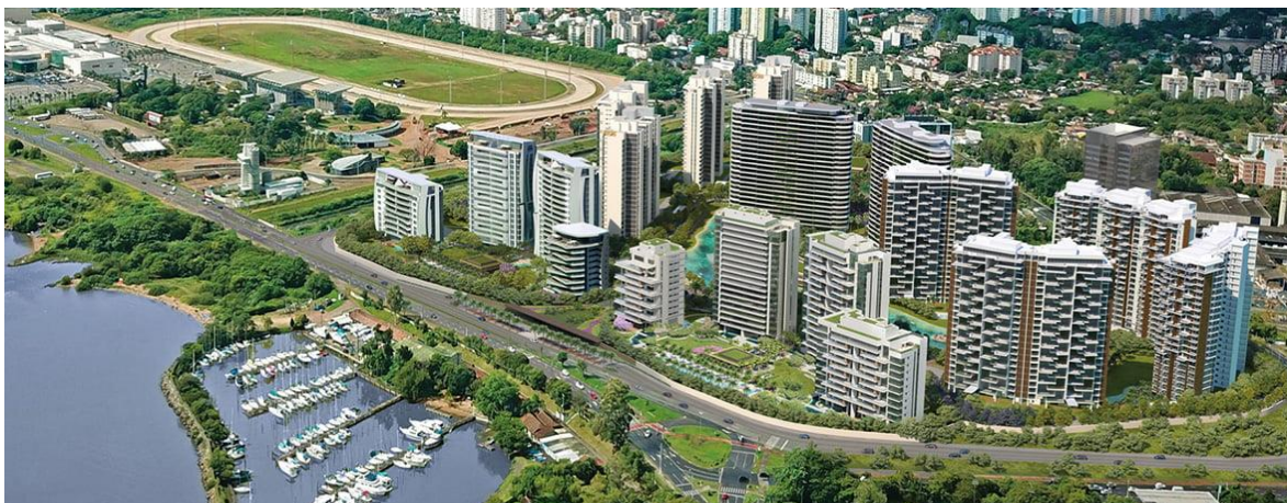
Figura 109: Empreendimento em construção na antiga área das cocheiras do Hipódromo*
