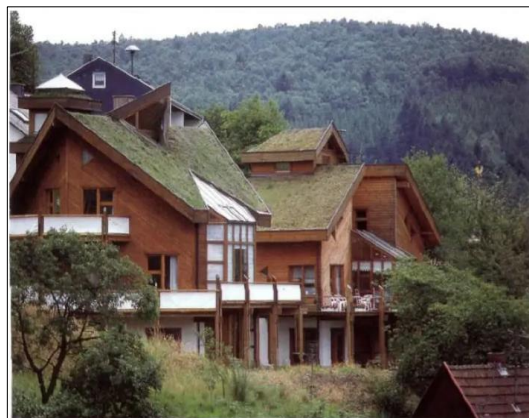
Figura 1: Telhado verde com inclinação de 45º - Siegen Oberscheiden (Alemanha) Fonte: Minke (2004, p. 19).
