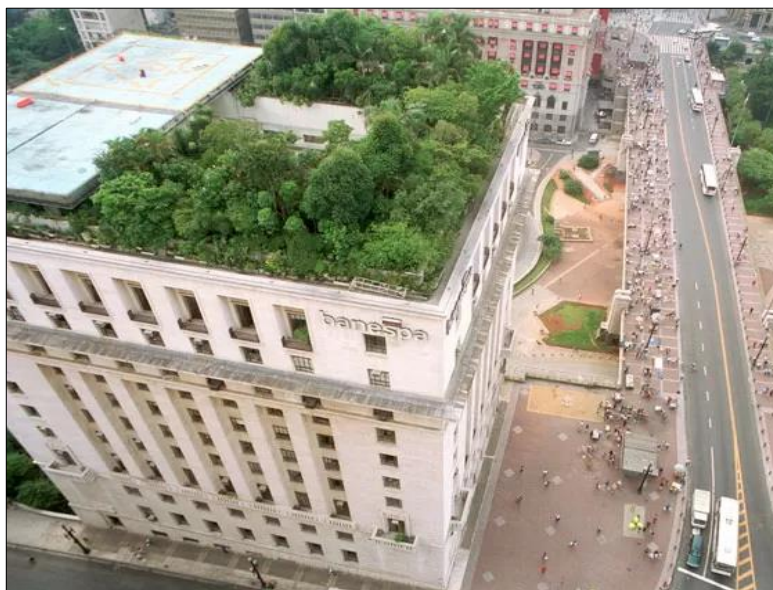
Figura 8: Telhado verde construído no edifício Matarazzo, atual sede da Prefeitura de São Paulo e antigo prédio do Banespa. Fonte: http://g1.globo.com/sao-paulo/noticia/2015/10/haddad-veta-obrigatoriedade-de-novos-predios-terem-telhado-verde.html Acesso em 19/04/2021.
