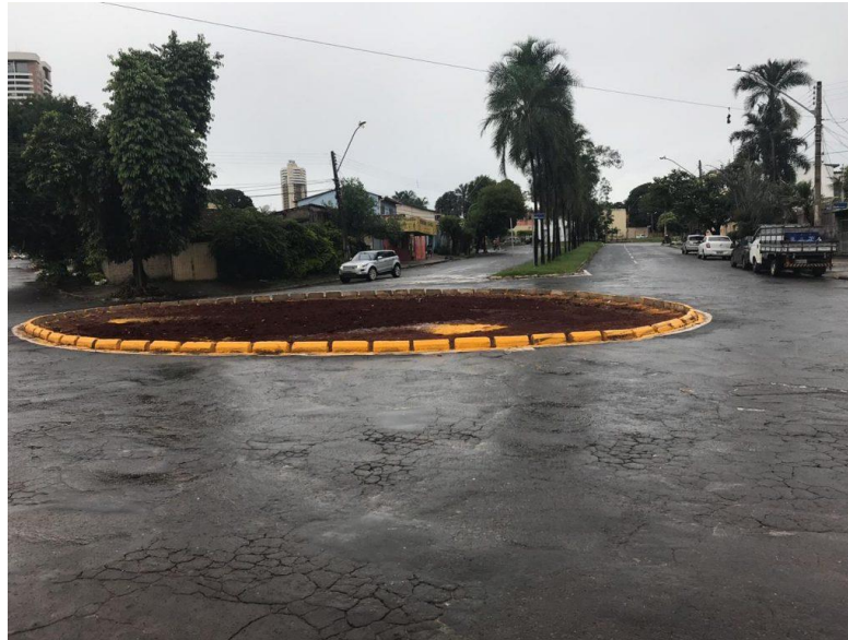
Figura 4 – Rotatória de instalação do Jardim de Chuva. Fonte: Leite e Melo (2019)
