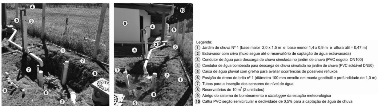
Figura 3 - Jardim de chuva dimensionado para avaliação de desempenho hidrológico.
