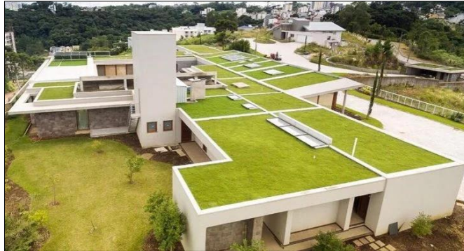
Figura 2: Telhado verde em superfície plana.
