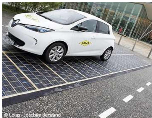
Figura 14 - Exemplo dos painéis *WattWay* aplicados na França. FONTE: Website da empresa COLAS
