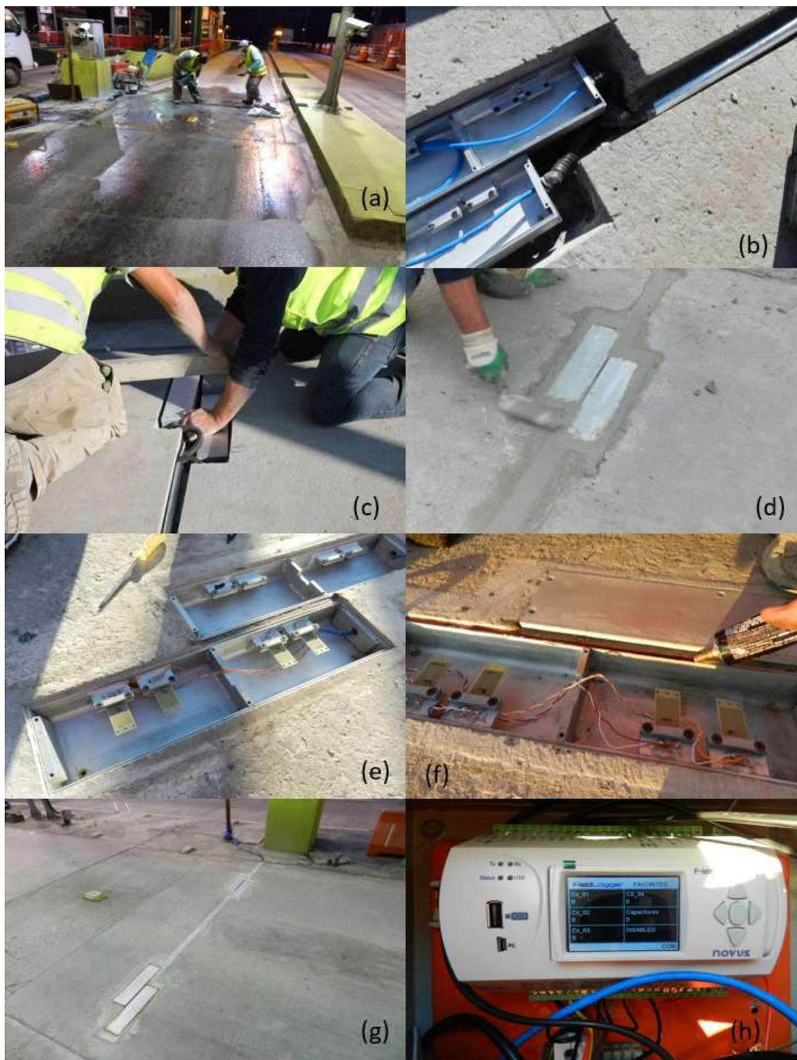
Figura 33 - Instalação dos corpos metálicos na Rodovia. (a) Preparação na via para instalação; (b) Colocação das caixas e eletrodutos nos cortes; (c) Nivelamento das caixas com o pavimento; (d) Preenchimento com graute acelerado (e) Colocação dos transdutores no local; (f) Impermeabilização das caixas com adesivo; (g) Caixas Finalizadas na via; (g) Fieldlogger configurado para recepção dos dados.
