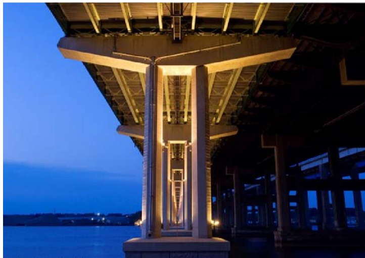
Figura 25. Tabuleiro exodérmico, ponte Driscoll, Nova Jersey (DePHILLIPS, 1985)
