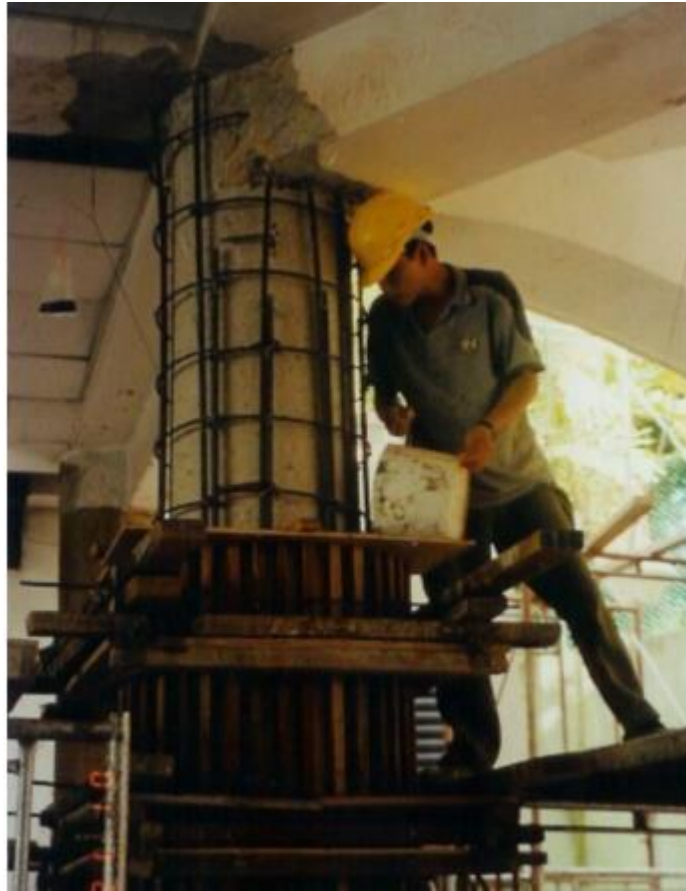
Figura 22. Encamisamento de pilar (CHHABRA, 2013)
