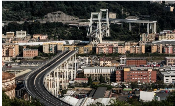
Figura 12. Colapso da ponte Morandi, Gênova-Itália (Disponível em: https://www.nytimes.com/interactive/2018/09/06/world/europe/genoa-italy-bridge.html , acessado em 10/03/19 as 17:56).
