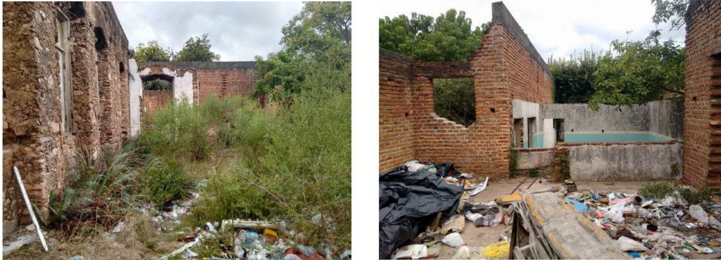
Figura 33: Fotografias do antigo casarão encontrado em Caçapava/RS, com os vestígios espalhados em seu interior.
