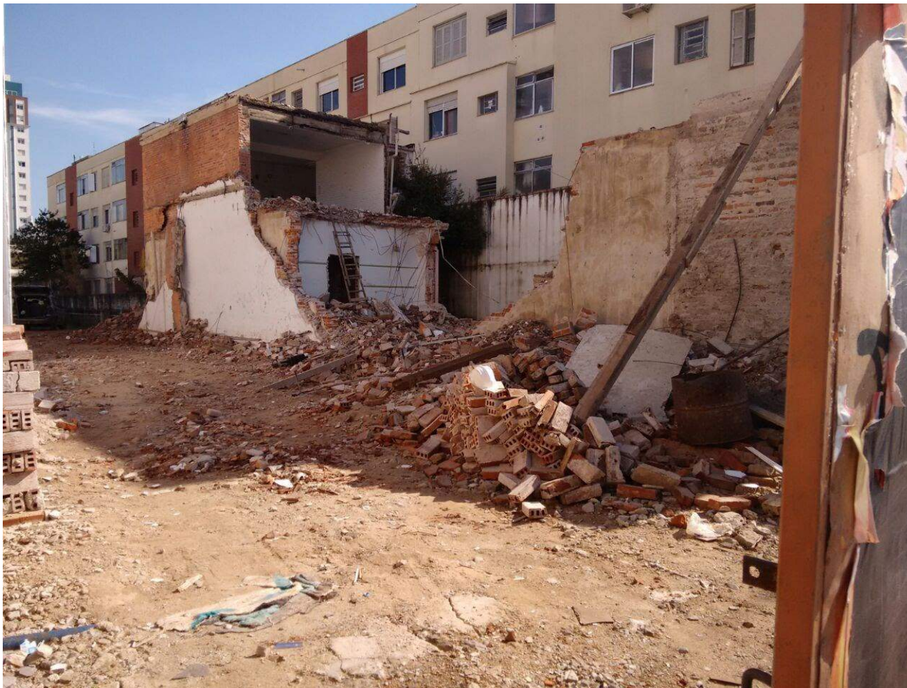
Figura 50: Fotografia da demolição na Av. João Pessoa. Porto Alegre/RS. 2017
