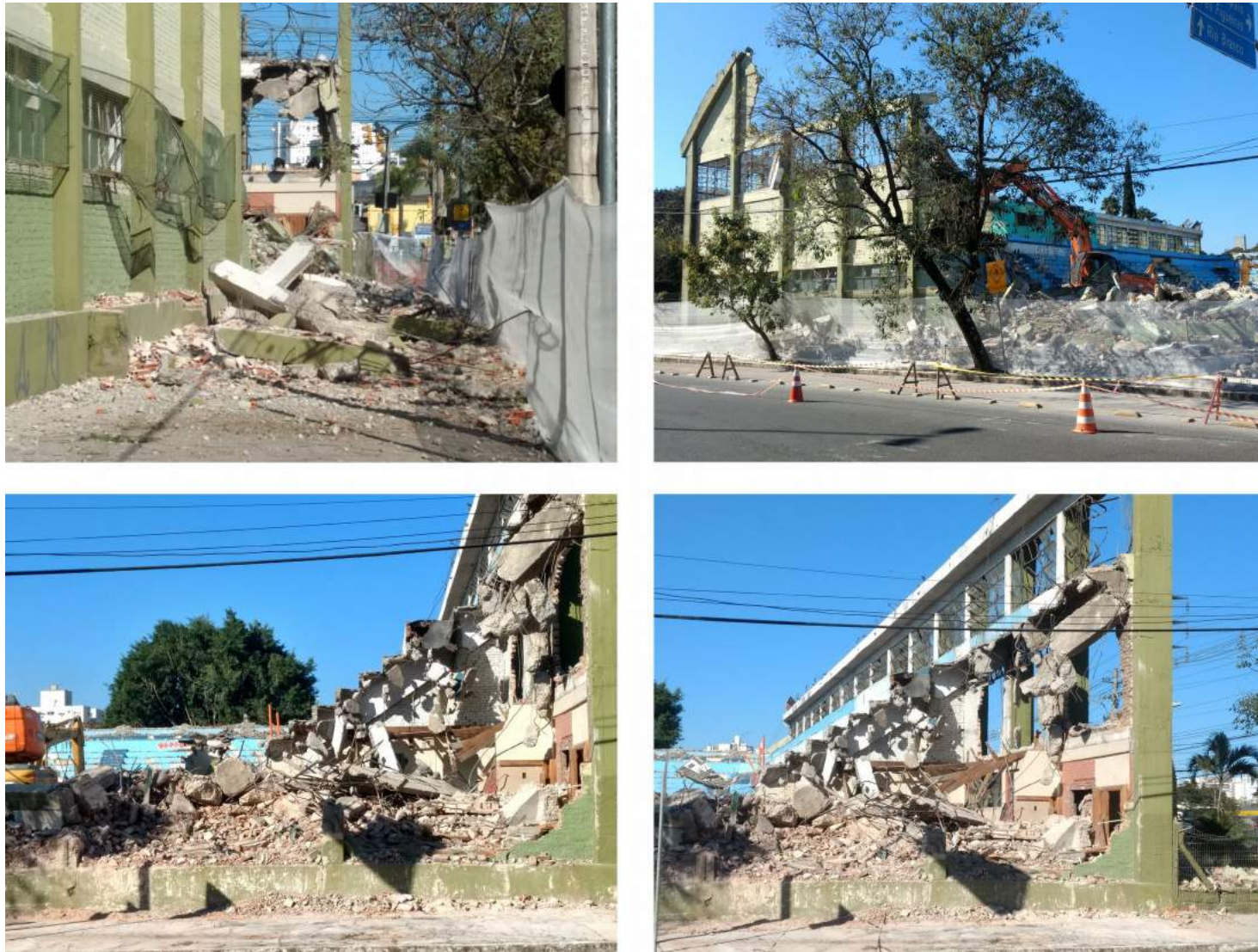
Figura 58: Registros da demolição do Ginásio da Brigada, Porto Alegre/RS, 2019.
