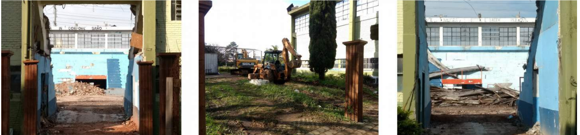
Figura 57: Imagens captadas antes da demolição completa do espaço, Porto Alegre/RS, 2019.
