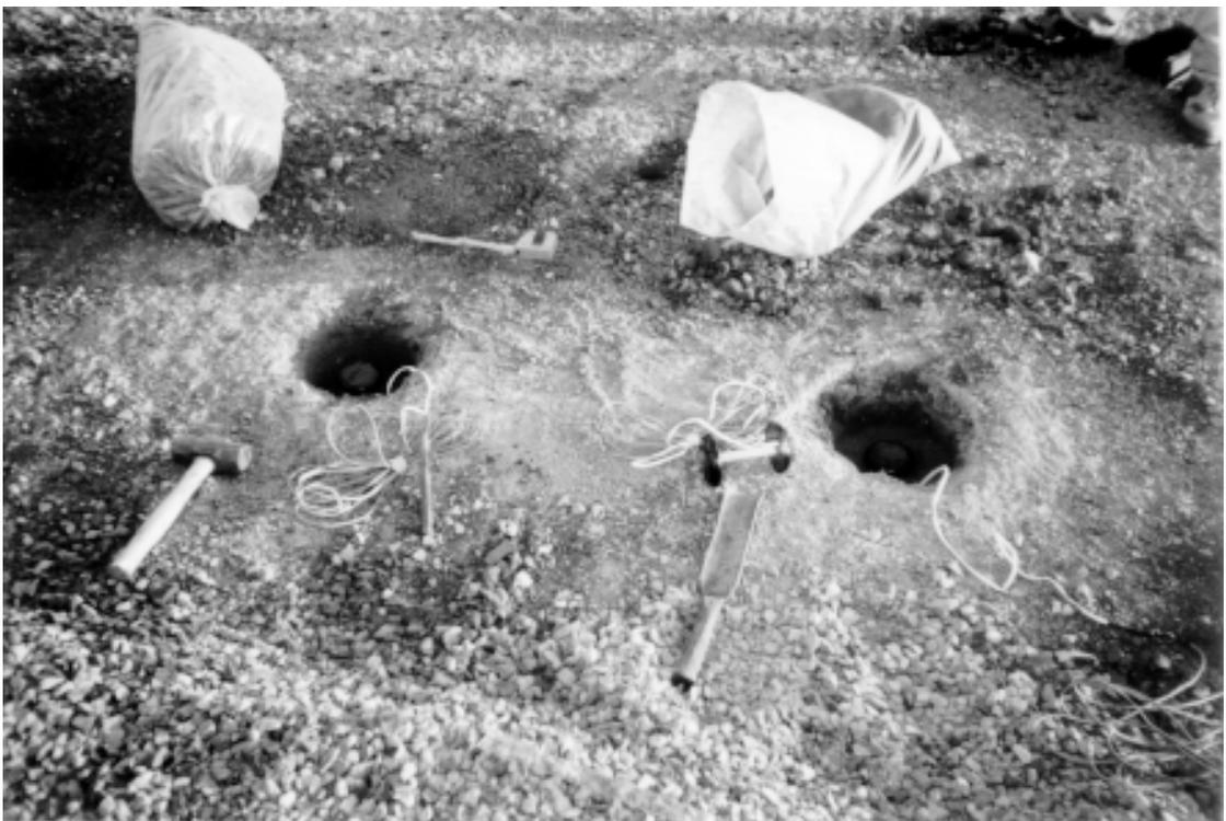
Figura 4.40: Furos para instalação dos sensores no subleito
