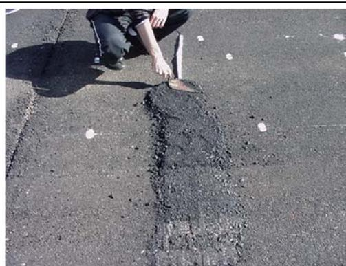
**Figura A8:** Instalação de *strain gages* na camada asfáltica
