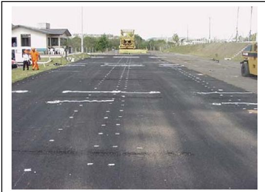
**Figura A9:** Instalação de *strain gages* na camada asfáltica
