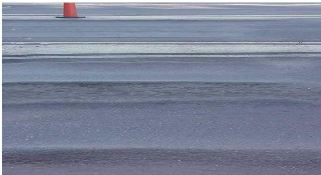
Figura 3.20: ATR em estrutura de pavimento flexível submetido a tráfego pesado
