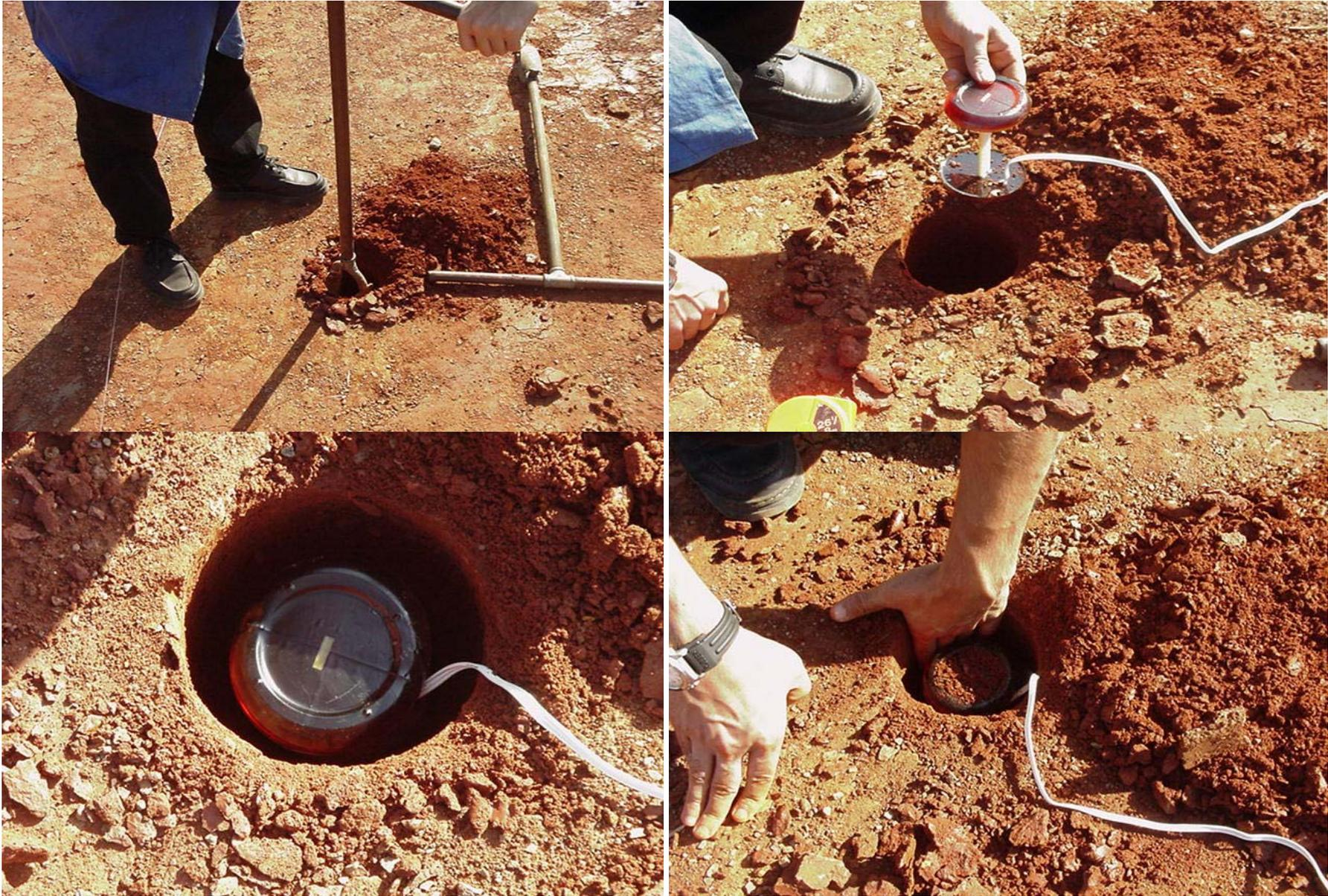
Figura 4.54: Instalação de *strain gages* no subleito (data 16/06/2000)
