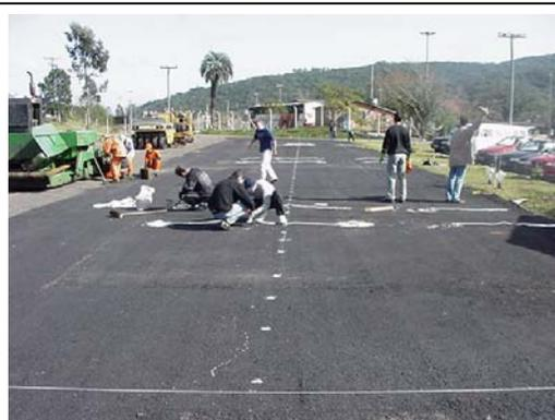
**Figura A10:** Execução do revestimento asfáltico
