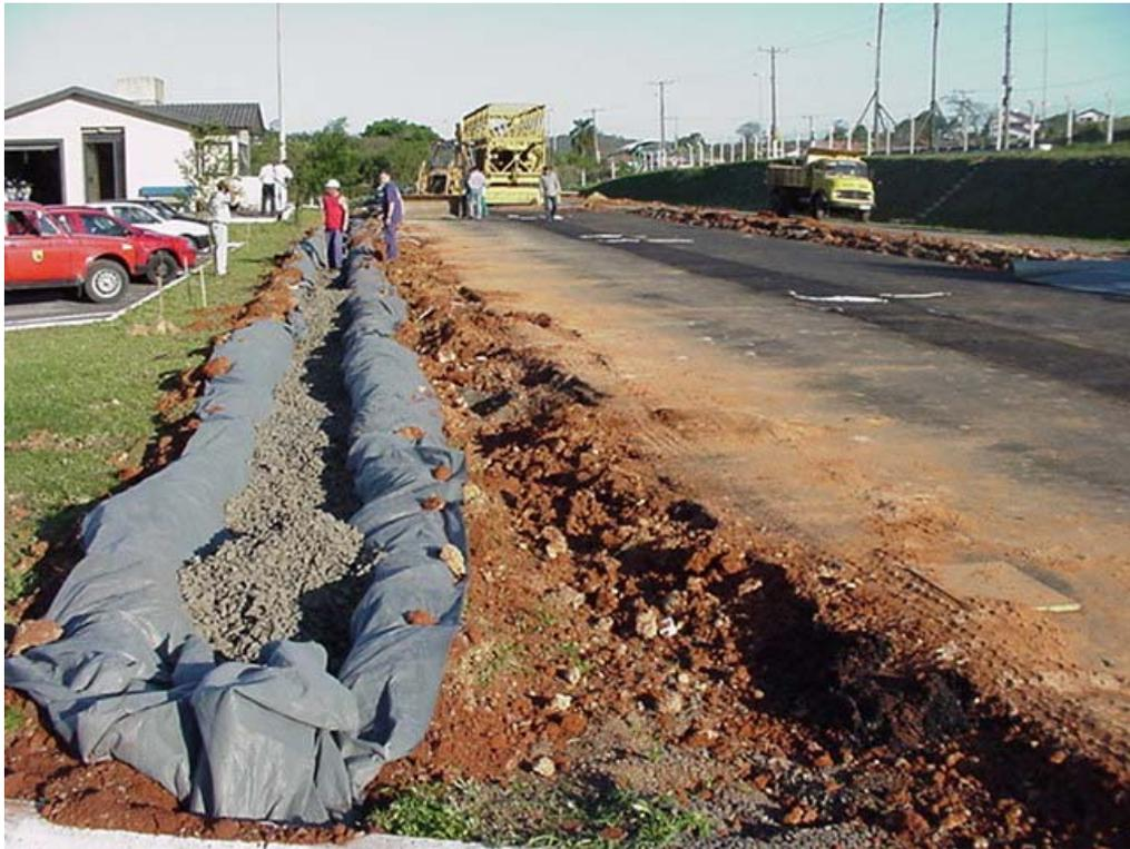
Figura 3.27: Sistema de drenagem das seções experimentais
