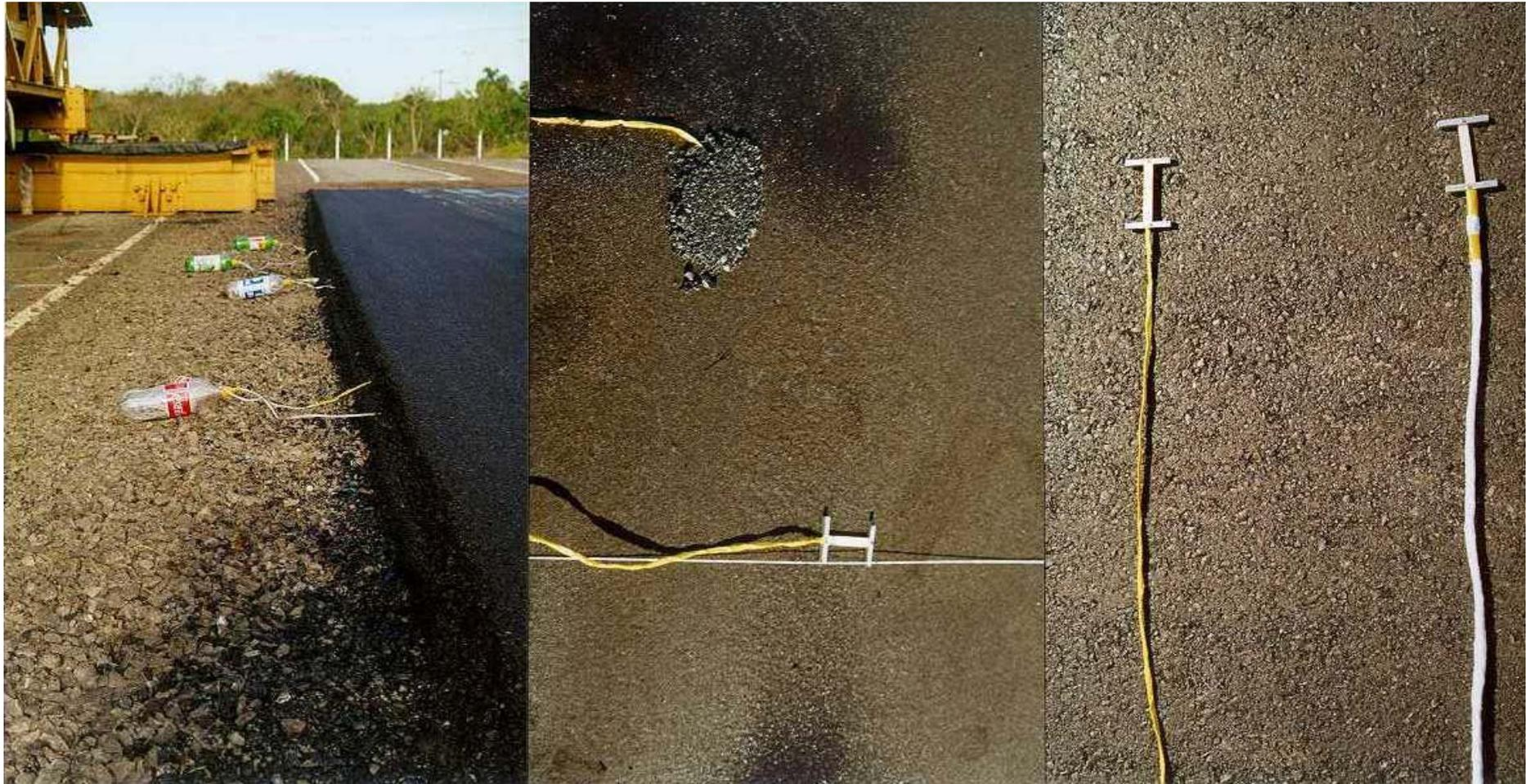
Figura 4.47: Instalação de extensômetros de resistência elétrica na face inferior da camada asfáltica
