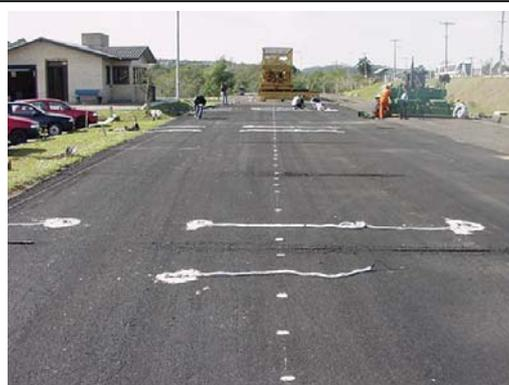
Figura A7: Instalação de *strain gages* na camada asfáltica
